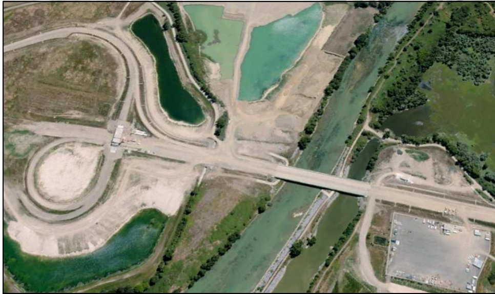
Photo 3 : déviation d'Aire-sur-l'Adour, ouvrage de franchissement de l'Adour
