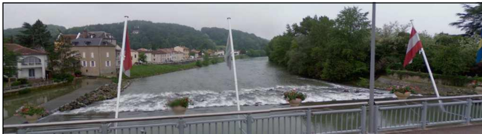
Photo 1 : seuil d'Aire-sur-l'Adour vu de l'amont
