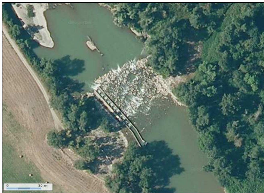
Photo 6 : Vue aérienne du seuil SNAEP
