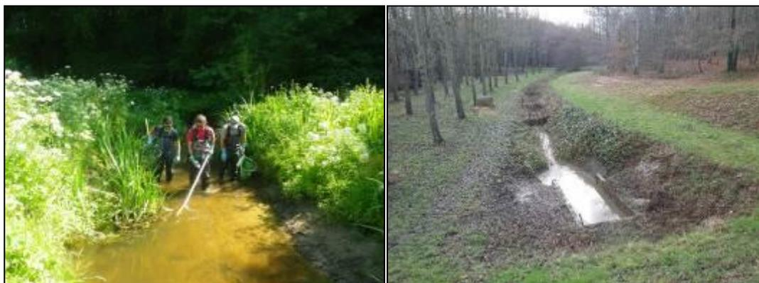
Figure 27 : Action de pêche électrique sur le Loc'h et mise en place de filtre à paille en amont d'une zone de travaux sur le Long
