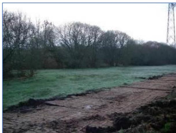
Figure 26 : Exemple d'un cheminement provisoire en bois qui protège le sol de la parcelle (bassin du Rion, chantier ERDF)
