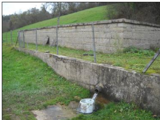
Réservoir semi-enterré
