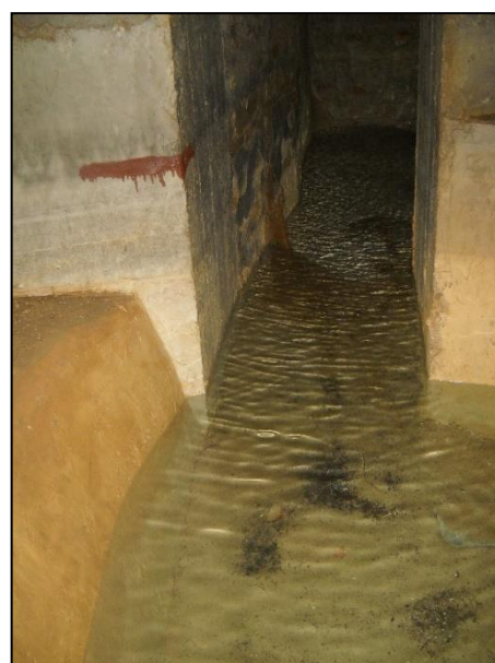
Figure 6 : Illustration photographique du site du captage de l'ancienne source
