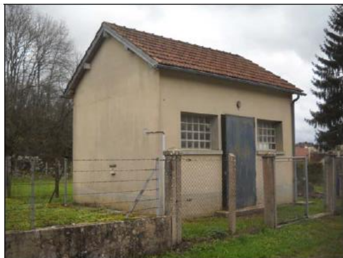
Station de traitement / distribution
