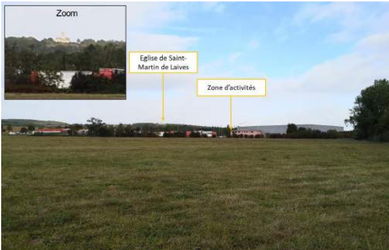
3) Vue depuis le site en direction du nord-ouest
