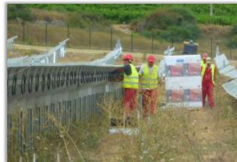
Câblage et interconnexion des modules photovoltaïques
