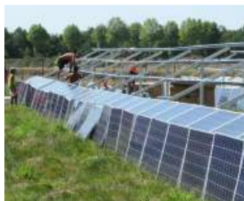
Pose manuelle des modules - Source : Luxel
