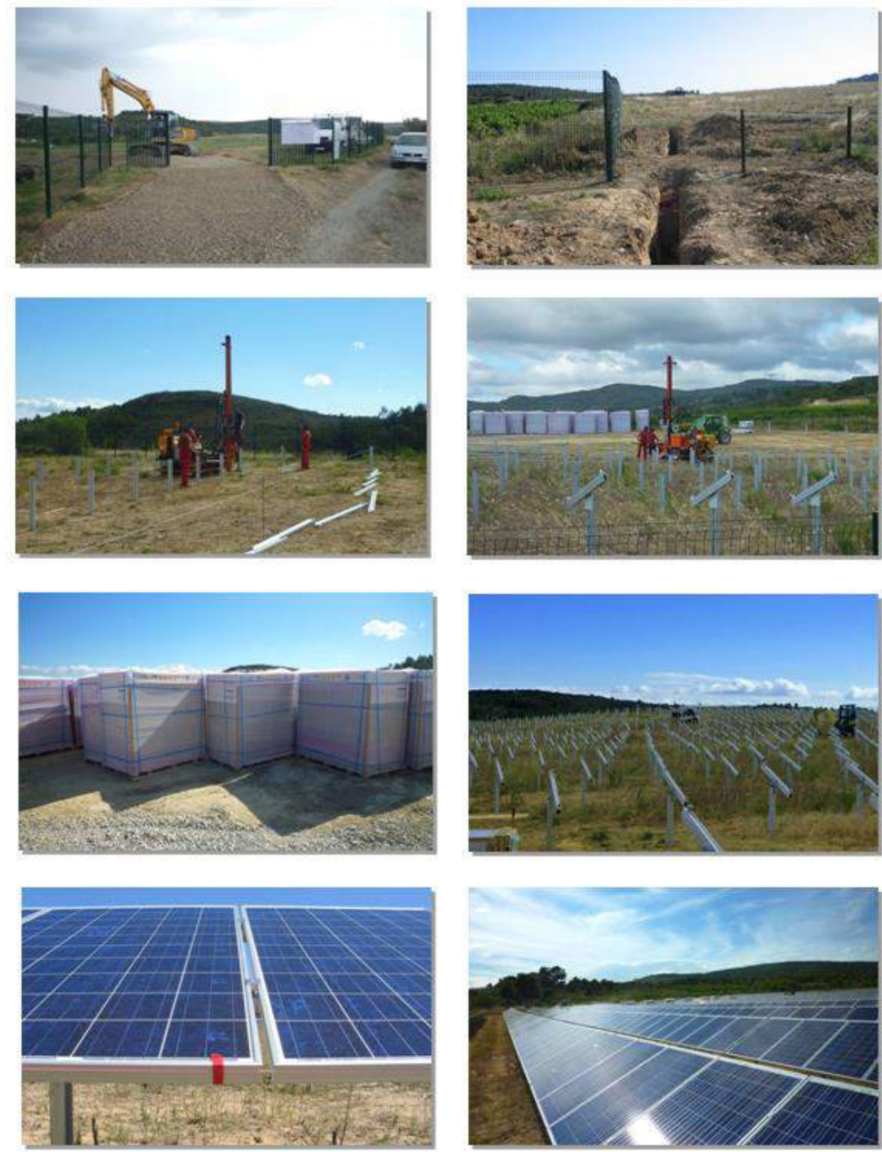
Présentation des différentes étapes du chantier (Source : LUXEL)
