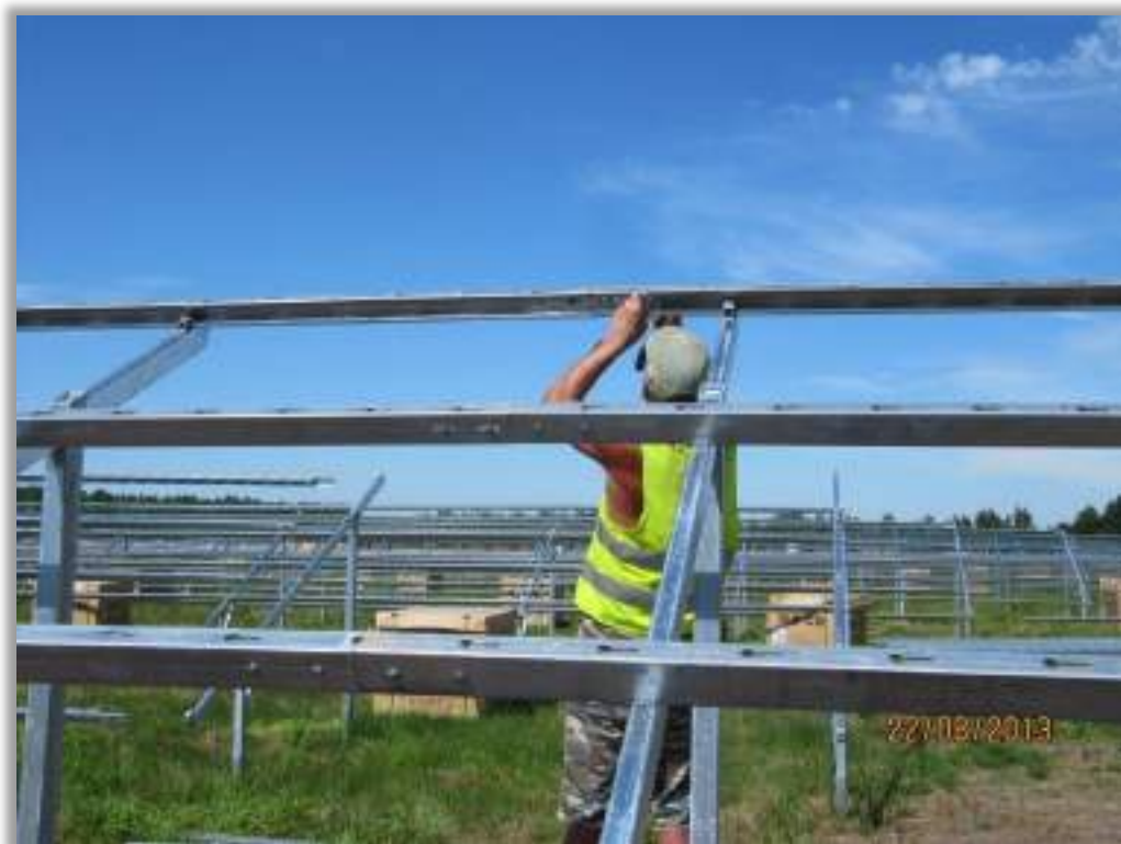
Systèmes de fixation pour installation photovoltaïque
