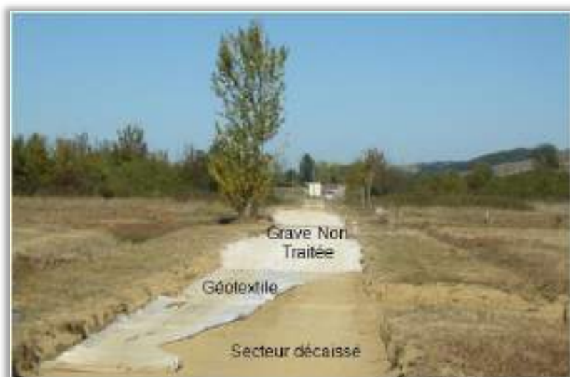
Mise en place d'une voie engins (lourde)
