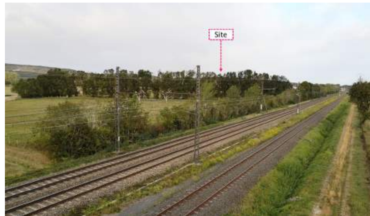
18) Vue depuis la route communale n°8 au niveau du pont sur la voie ferrée
