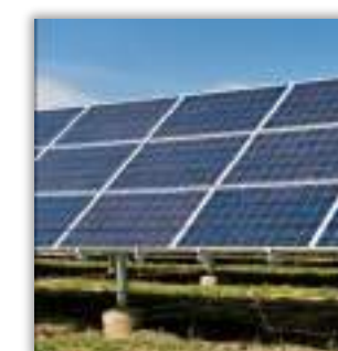
sur plots béton
