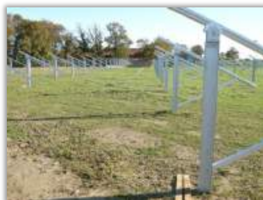
Structures prêtes à recevoir des modules
