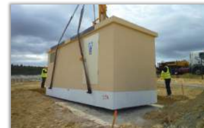
Schéma de dépose des postes préfabriqués - Source : Transfix Photo de pose de poste préfabriqué
