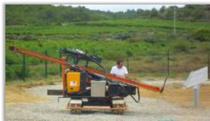
Machine de battage de pieux
