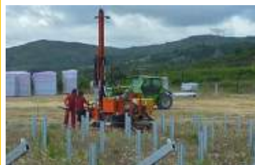
Battage des pieux
