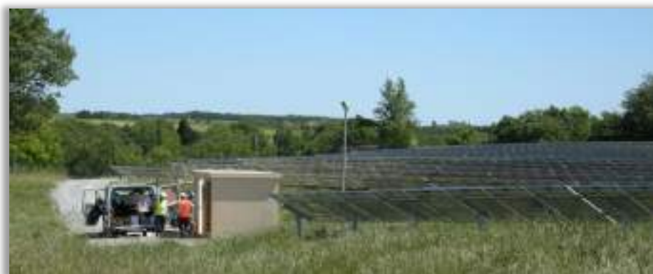
Opération de maintenance
