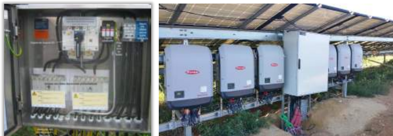
Éléments constitutifs d'une boîte de jonction Boîte de jonction, onduleurs et câbles à l'arrière des panneaux -
