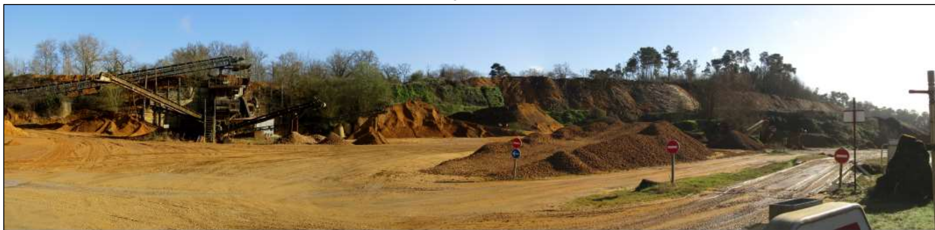
Vue sur l'aire de stockage depuis l'entrée du site industriel de Menjun
