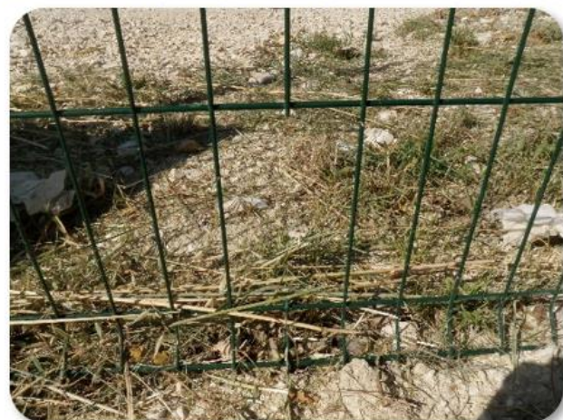
Photo 24 : Création de passage à faune par clôture spécifique perméable
