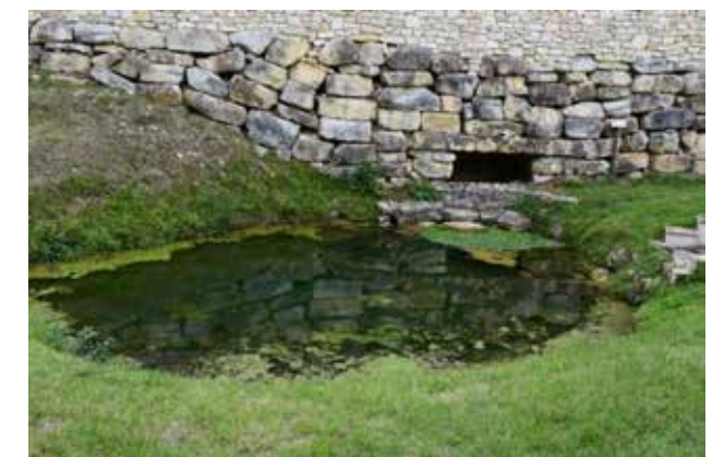
Figure 66 : Lavoir de Tressèroux
