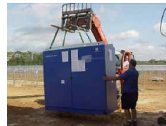
Figure 98 : Exemple d'acheminement d'un poste de livraison préfabriqué (source : VALECO, 2021)
