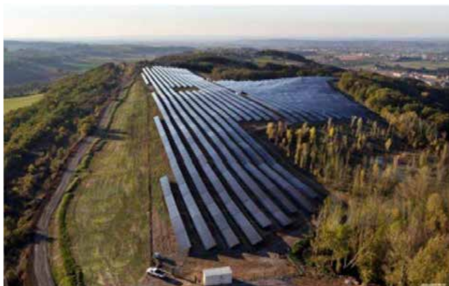
Figure 91 : Exemple de centrale solaire structure fixe de la société VALECO : (source : VALECO, 2021)
