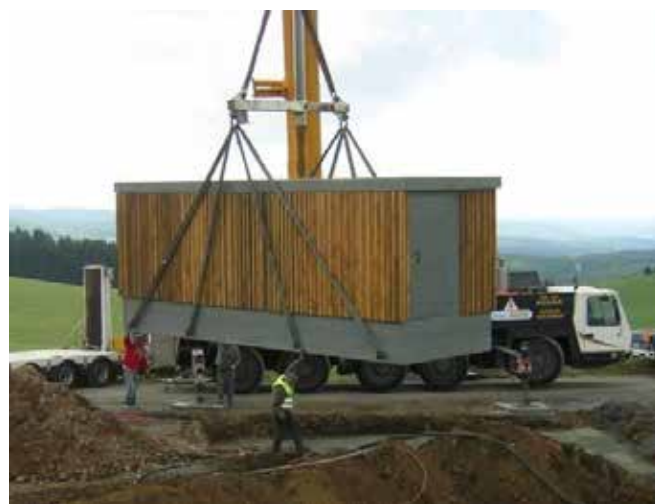
Figure 93 : Illustration de livraison d'un poste de transformation électrique sur un parc éolien (source : VALECO, 2021)
