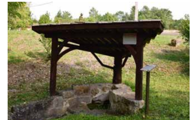
Figure 64 : Lavoir des Peyrières
