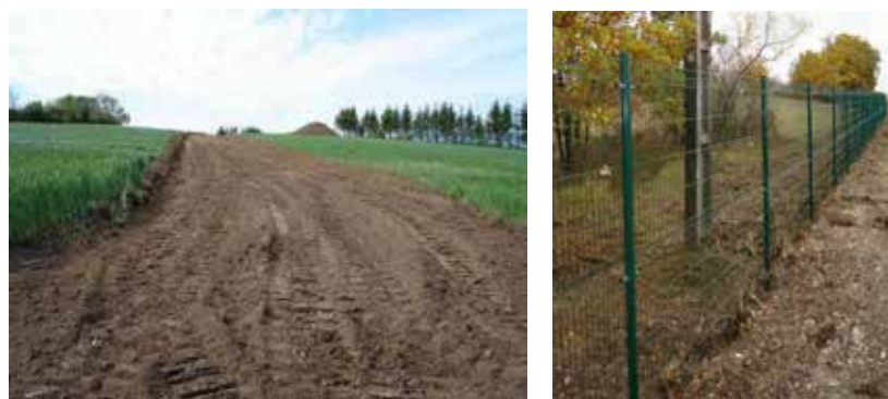
Figure 95 : Illustrations de la préparation du site (source : VALECO 2021)
