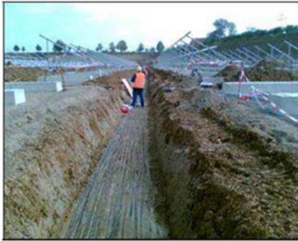
Figure 28 : Exemple tranchée dédiée aux câbles
