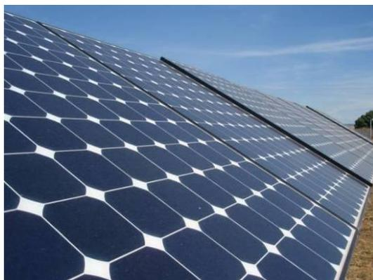
Figure 18 : exemple de panneaux monocristallin
