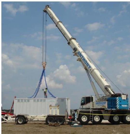
Figure 29 : Engin utilisé pour la pose des postes de transformation
