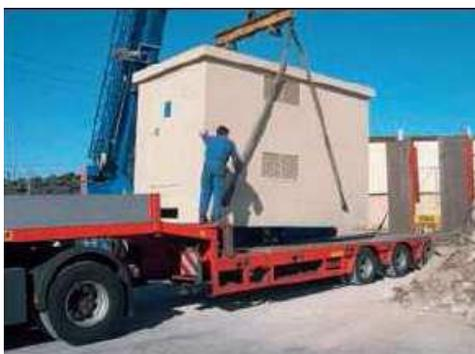
Figure 31 : Déchargement d'un poste électrique
