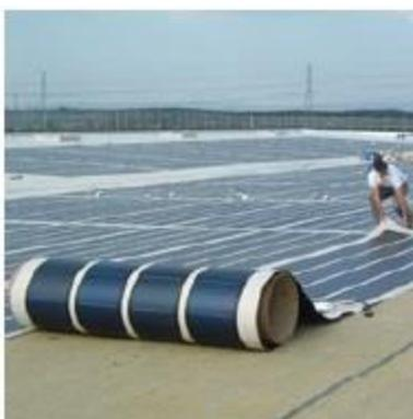
**Figure 13 : Exemple de silicium amorphe (source Urbasolar)**
