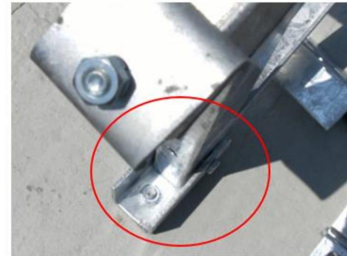
Figure 22 : Vue d'un étrier supportant les tables de panneaux
