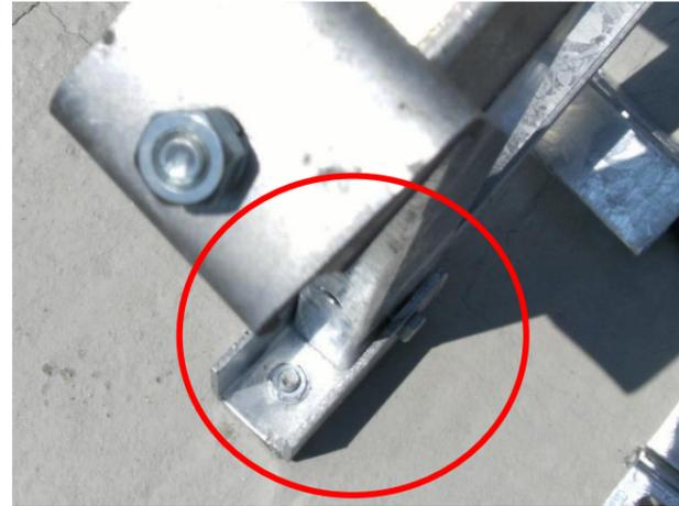
Sur la photo l'étrier supportant la structure est visé dans une surface dure
