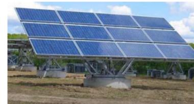
Figure 11 : Structure bi-axiale – source :
