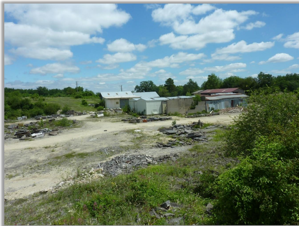
Figure 4 : Vue sur la zone d'implantation 1 (zone Nord-Ouest)
