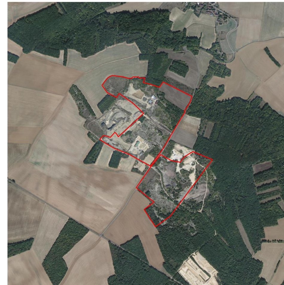
Figure 12 : Photo aérienne de la zone d'implantation potentielle
