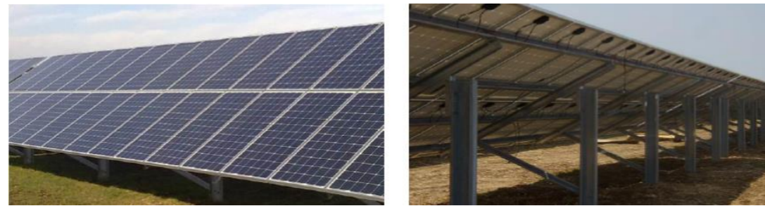
Figure 5 – Exemples de fondations sur pieux
