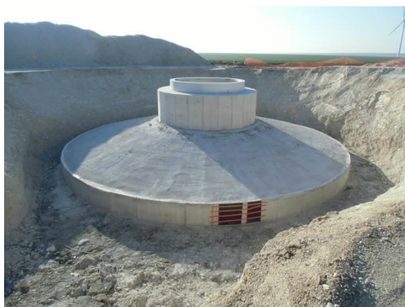
Figure 1-8 : Vue du massif béton de fondation d'une éolienne
