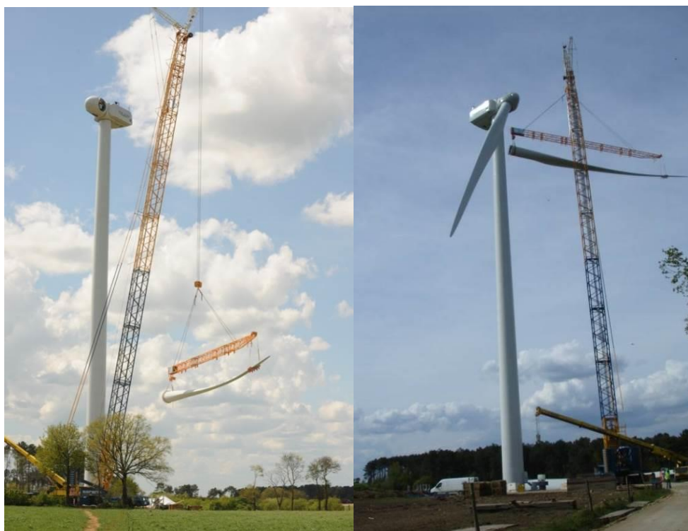
Figure 1-19 : Montage des première et seconde pales au rotor
