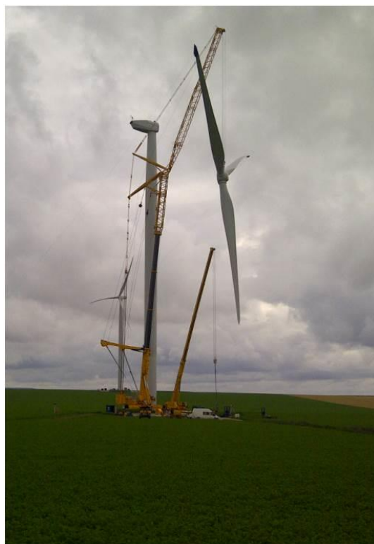
Figure 1-20 : Vue de l'assemblage du rotor
