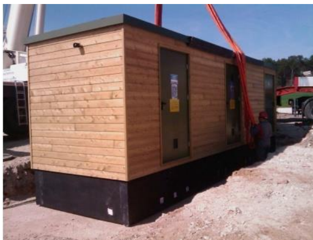
Figure 1-11 : Exemple de poste de livraison
