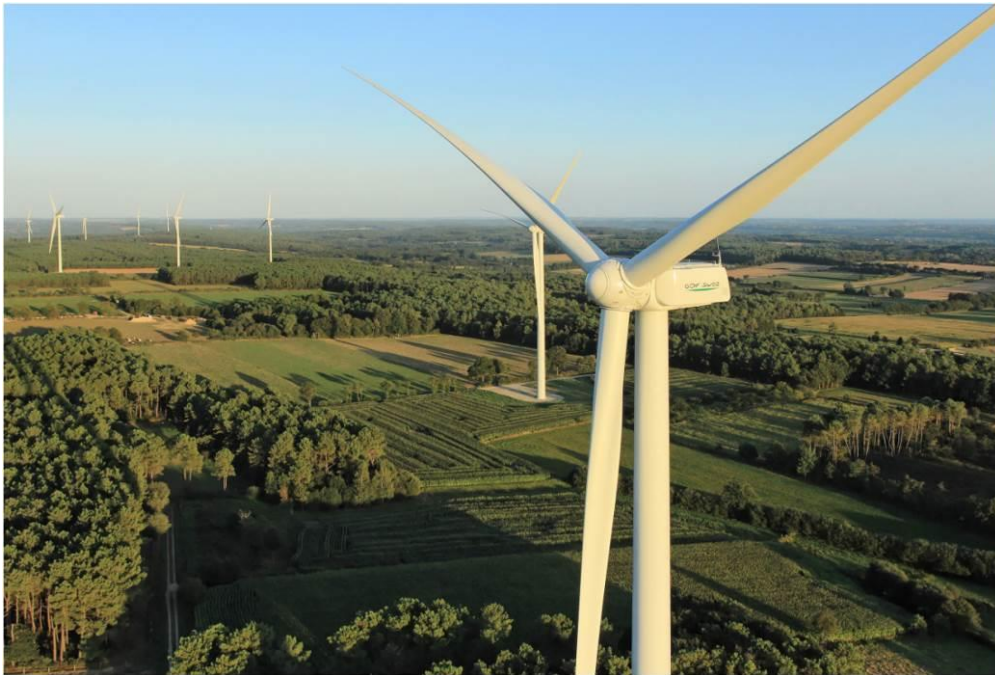
Figure 1-22 : Vue sur les éoliennes montées
