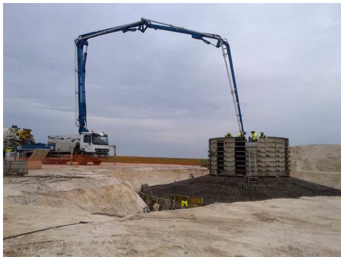
Figure 1-15 : Mise en place des fondations (coulage du béton)
