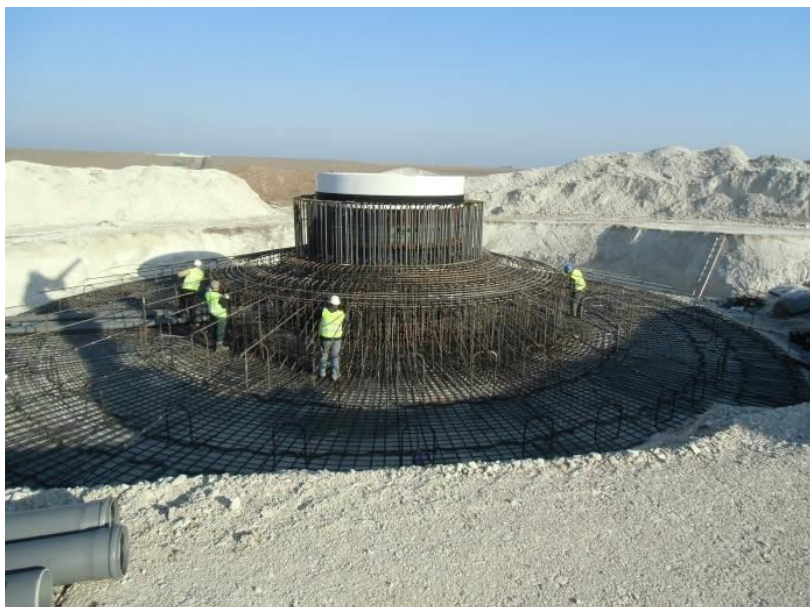
Figure 1-14 : Mise en place des fondations (ferraillage)
