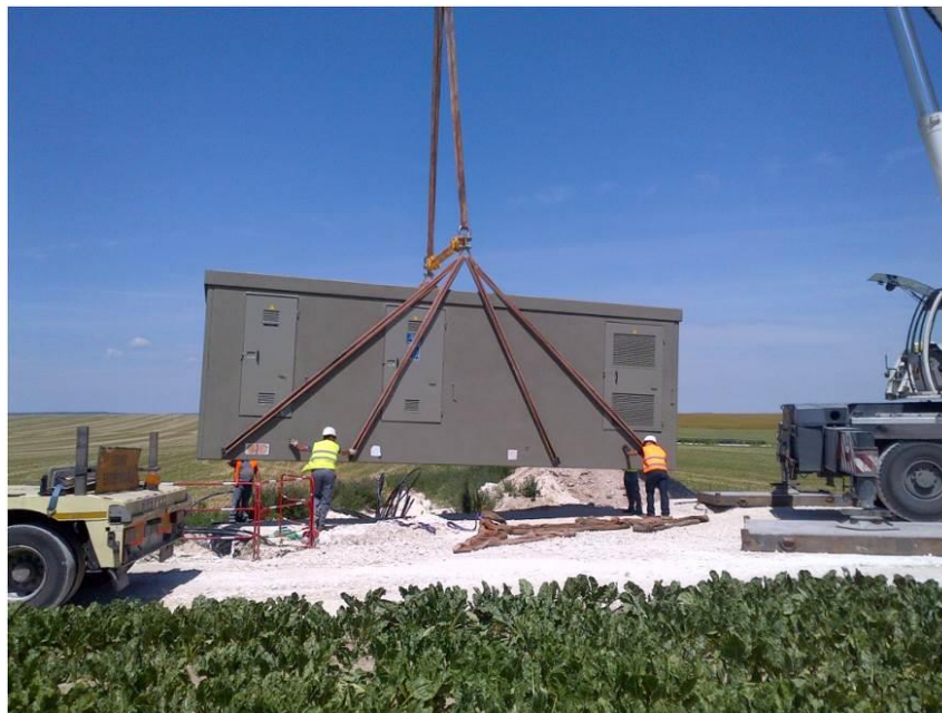
Figure 1-23 : Mise en place du poste de livraison
