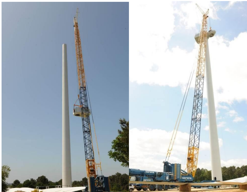
Figure 1-18 : Levage de la nacelle et assemblage du rotor à la nacelle
