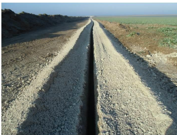
Figure 1-16 : Tranchées pour la mise en place des câbles
