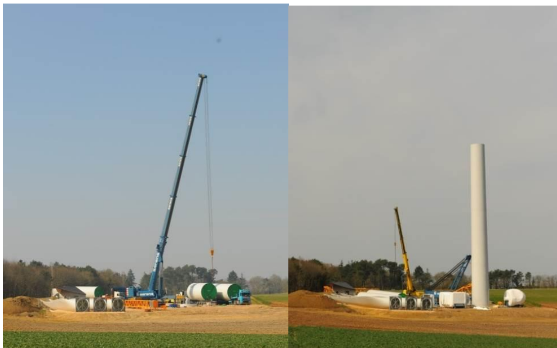
Figure 1-17 : Déchargement d'éléments du mât et montage
