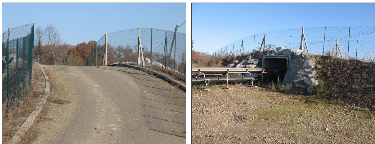
Vue sur le dispositif de franchissement du tapis de plaine
