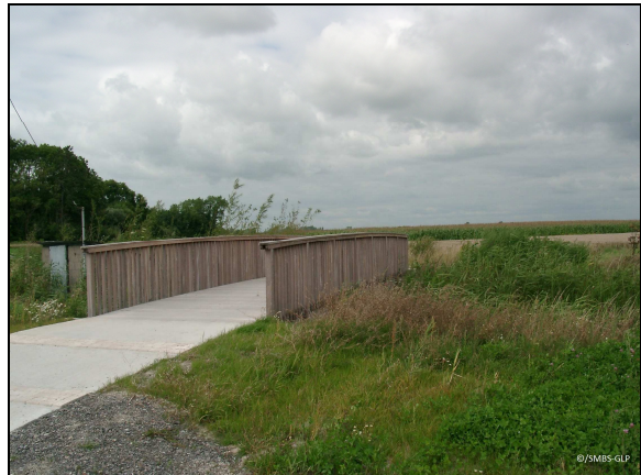
Ouvrage de franchissement d'un cours d'eau aménagé par le SMBSGLP
