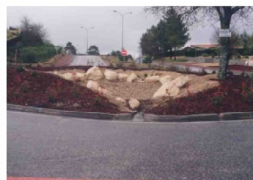
Photo 8 : Puits d'infiltration (Copyright : Siba)
