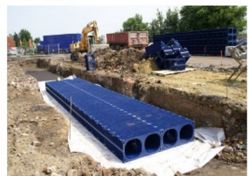
Photo 9 : Mise en oeuvre d'une chaussée à structure-réservoir (Copyright : CA du Douaisis)
