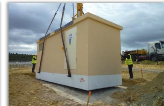
**Schéma de dépose des postes préfabriqués - Source : Transfix**
