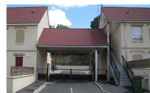
Porche d'entrée du parking
