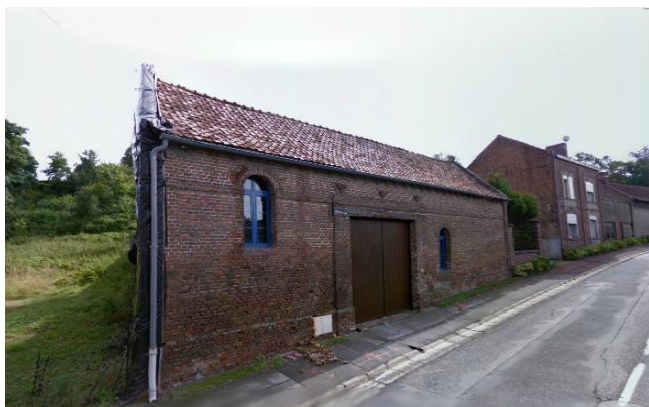
Avant .... (constructions initiales démolies)
