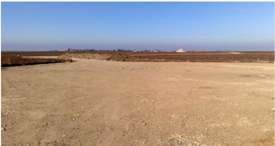
Figure 67 : Exemple d'aire de montage, grave compactée sur géotextile
