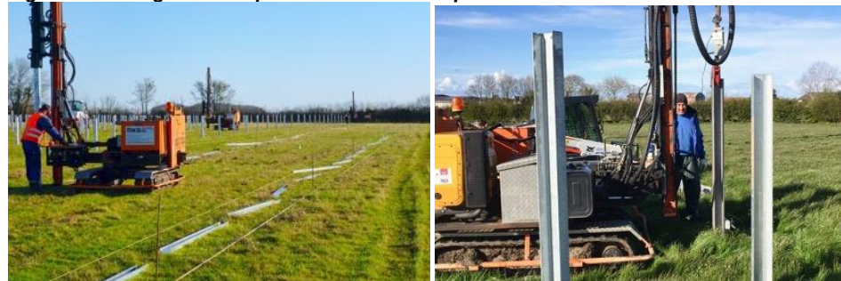
Figure 128 : Images d'exemple d'une batteuse de pieux
