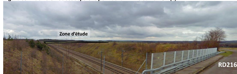
Figure 63 : Vue vers l'Ouest depuis le pont de la RD216 sur la LGV (9)
