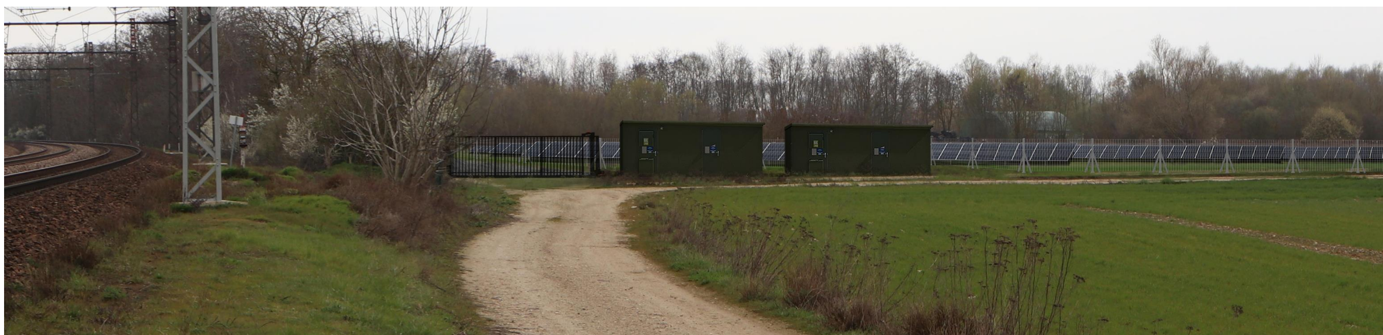
Figure 60 : Photomontage n°6 – Vue rapprochée des postes de livraison à l'entrée sud du parc photovoltaïque à Etigny – Etat projeté
