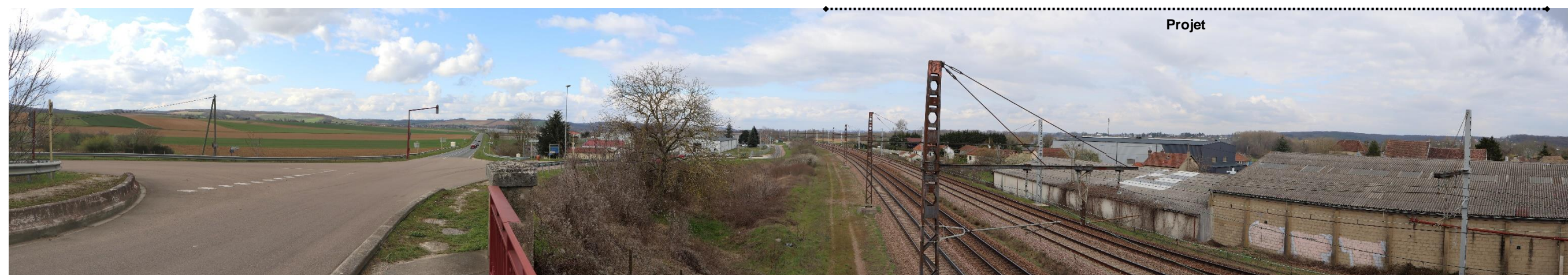
Figure 114 : Depuis le pont routier de la D72 enjambant la voie ferrée (ligne du TER), au nord d'Étigny (©ATER Environnement, 2021)
