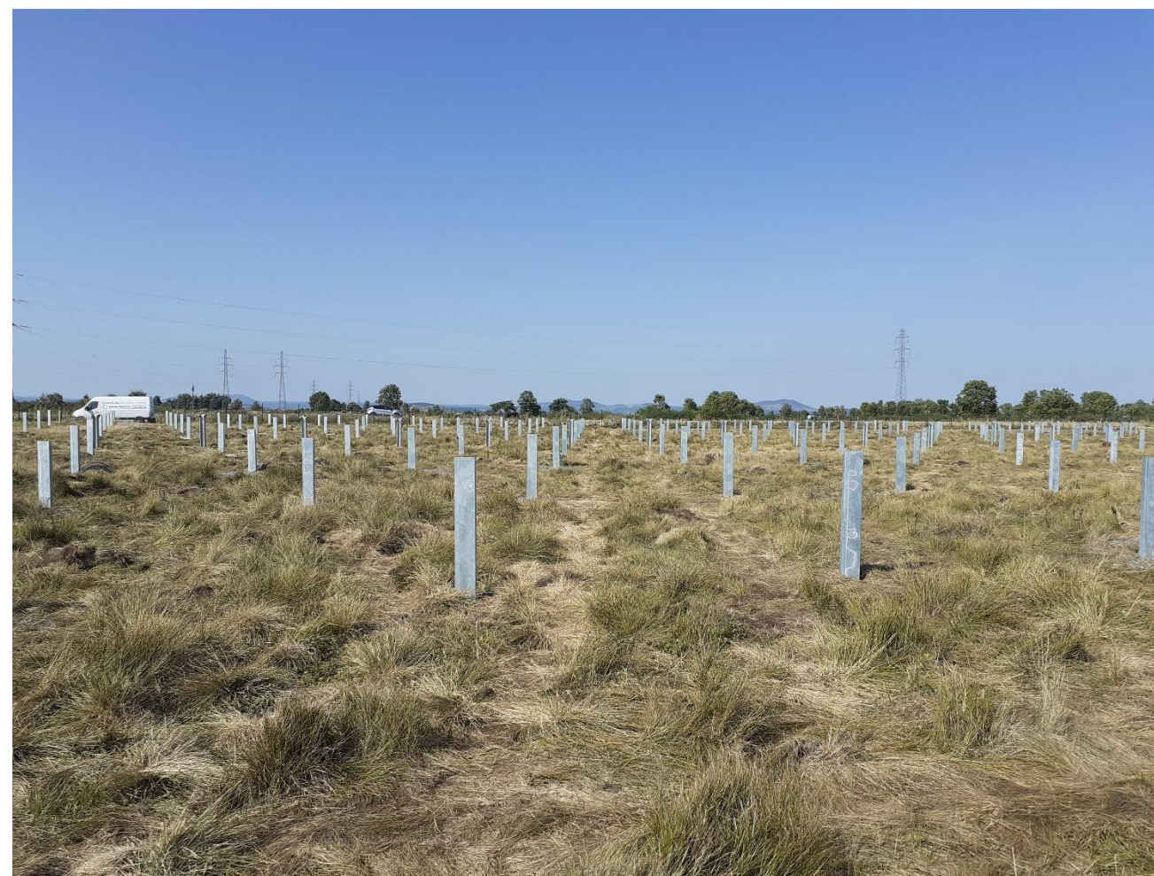
Figure 89 : Illustration de pieux forés – Parc de la Clef des Champs (source : BORALEX, 2021)
