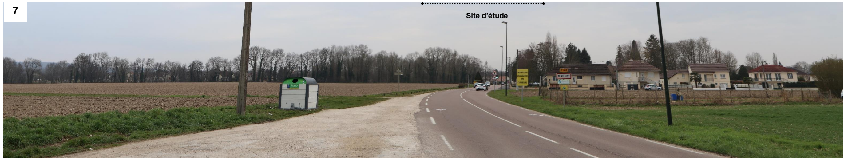
Figure 31 : Vue sur l'entrée nord de Maillot depuis le sud-est de Sens, depuis la D146 (©ATER Environnement, 2021)
