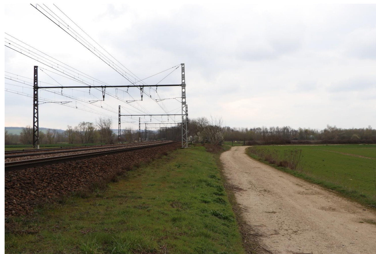
Figure 78 : Voie ferrée et chemin d'exploitation en bordure Ouest du projet. Le site d'étude est situé en arrière-plan (source : ATER Environnement, 2021)
