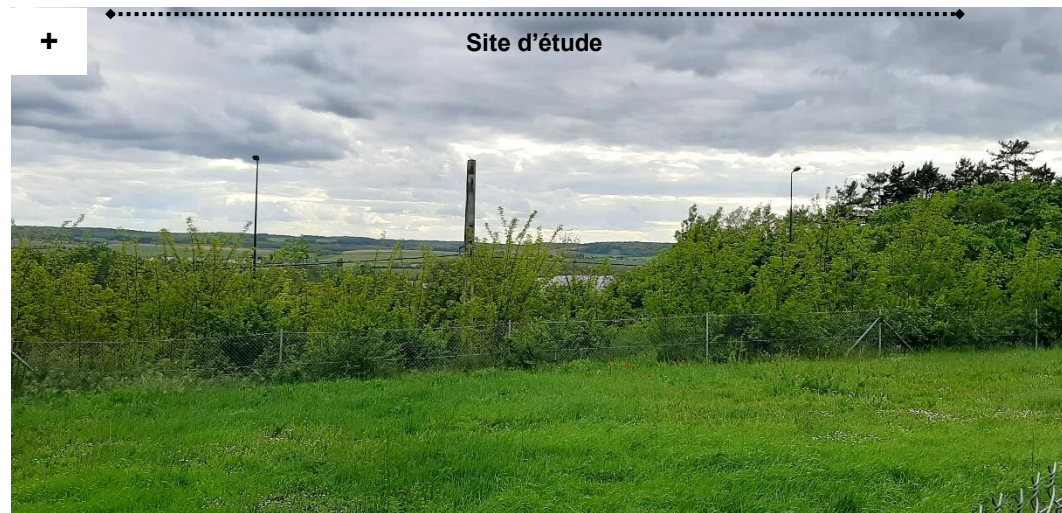
Figure 47 : Depuis l'extrémité nord du Chemin des Violettes à Rosoy, où la vue sur le plan d'eau du site d'étude est fortement filtrée par la végétation bordant la D606 en contrebas (©BORALEX, mai 2021)
