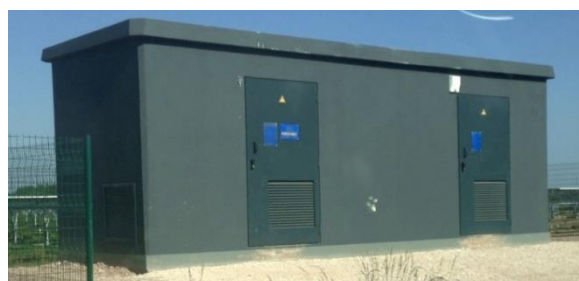
Figure 95 : Illustration d'un poste de livraison
