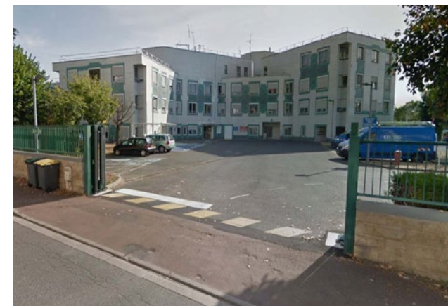
Déménagement de l'entreprise ENEDIS ©GoogleMaps
