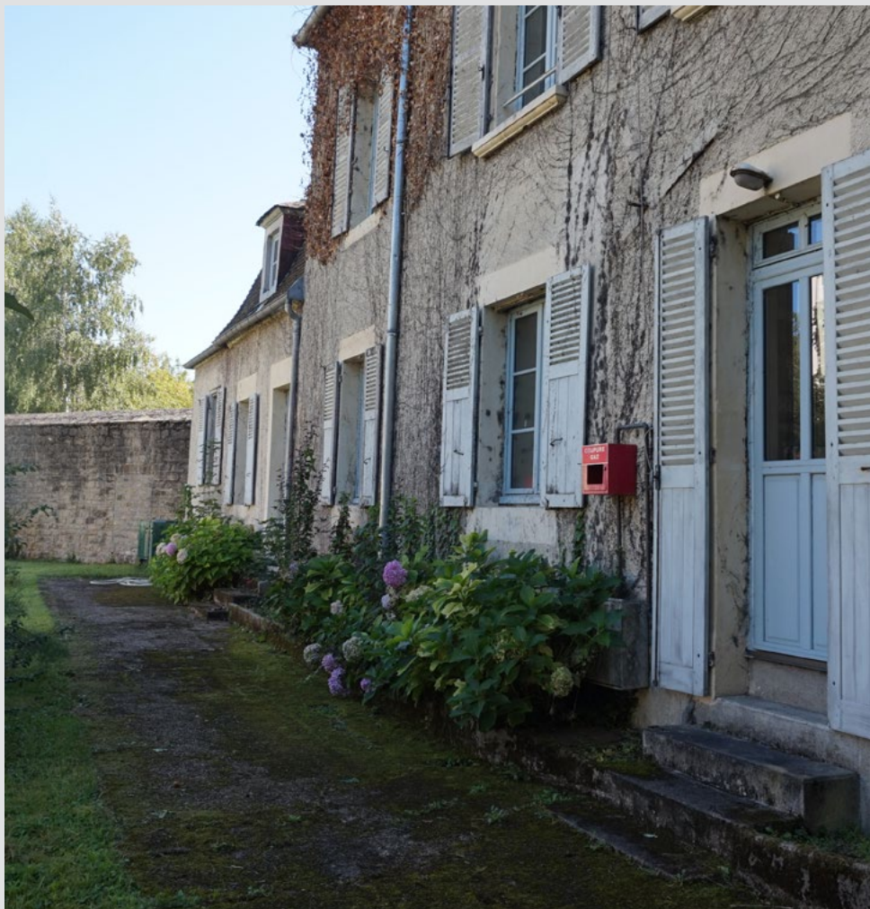
Bâtiment G (1850) : 320 m 2 SHON - R+1
