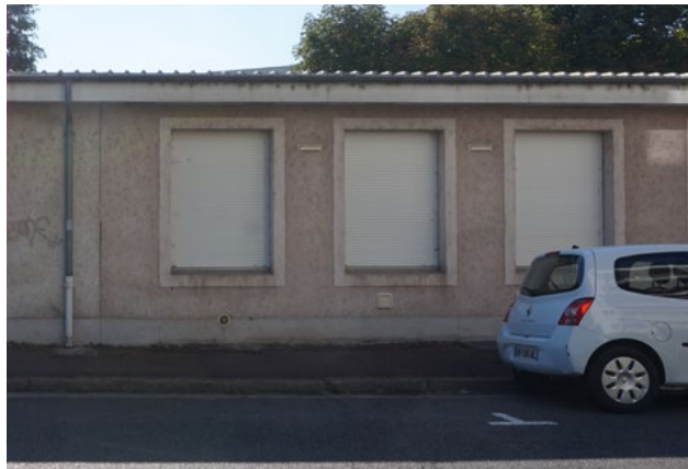
Bâtiment F (1980) : 267 m 2 SHON - RDC (VNF)
