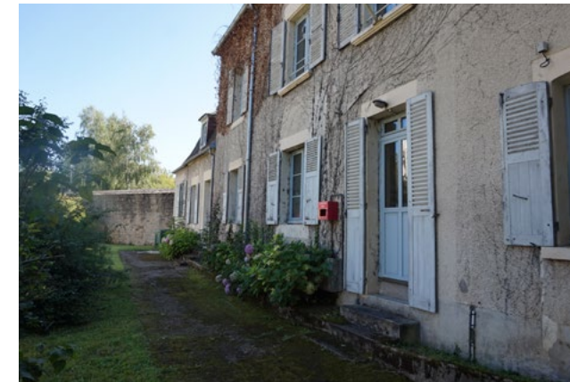
Bâtiment G (1850) : 320 m 2 SHON - R+1
