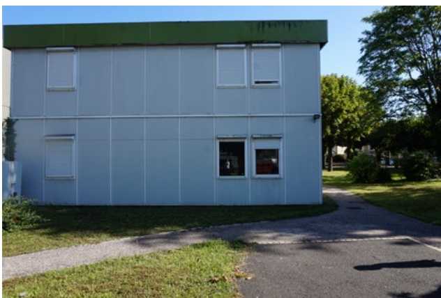
Bâtiment E (1991) : 604 m 2 SHON - R+1 (VNF)
