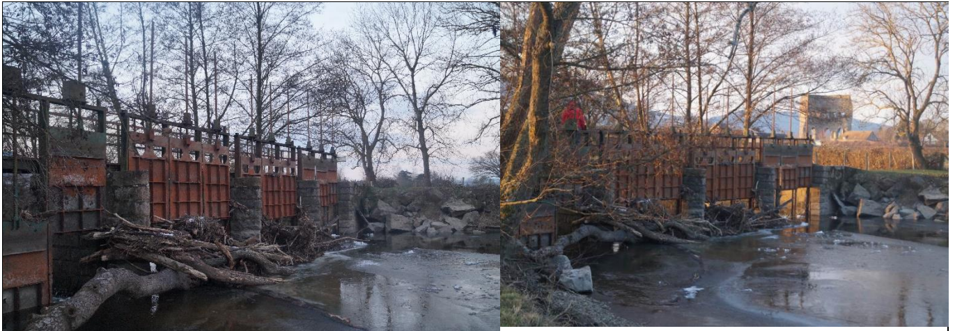
Interception des embâcles par le barrage
