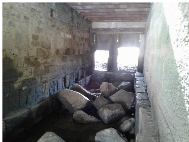
Barrage avec embâcles
