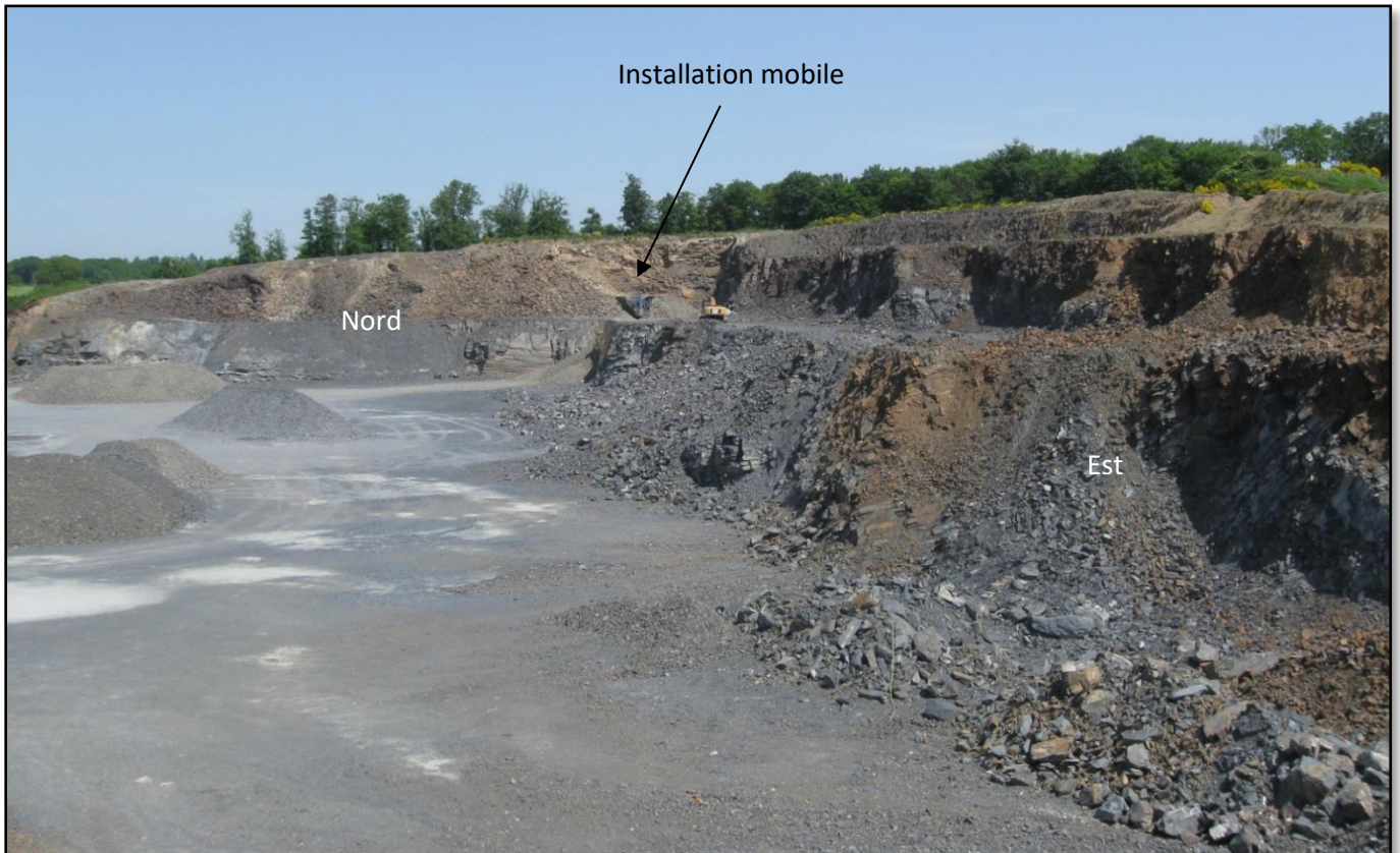
Photographie 1 : Vue globale des fronts de taille (Nord et Est) depuis le carreau
