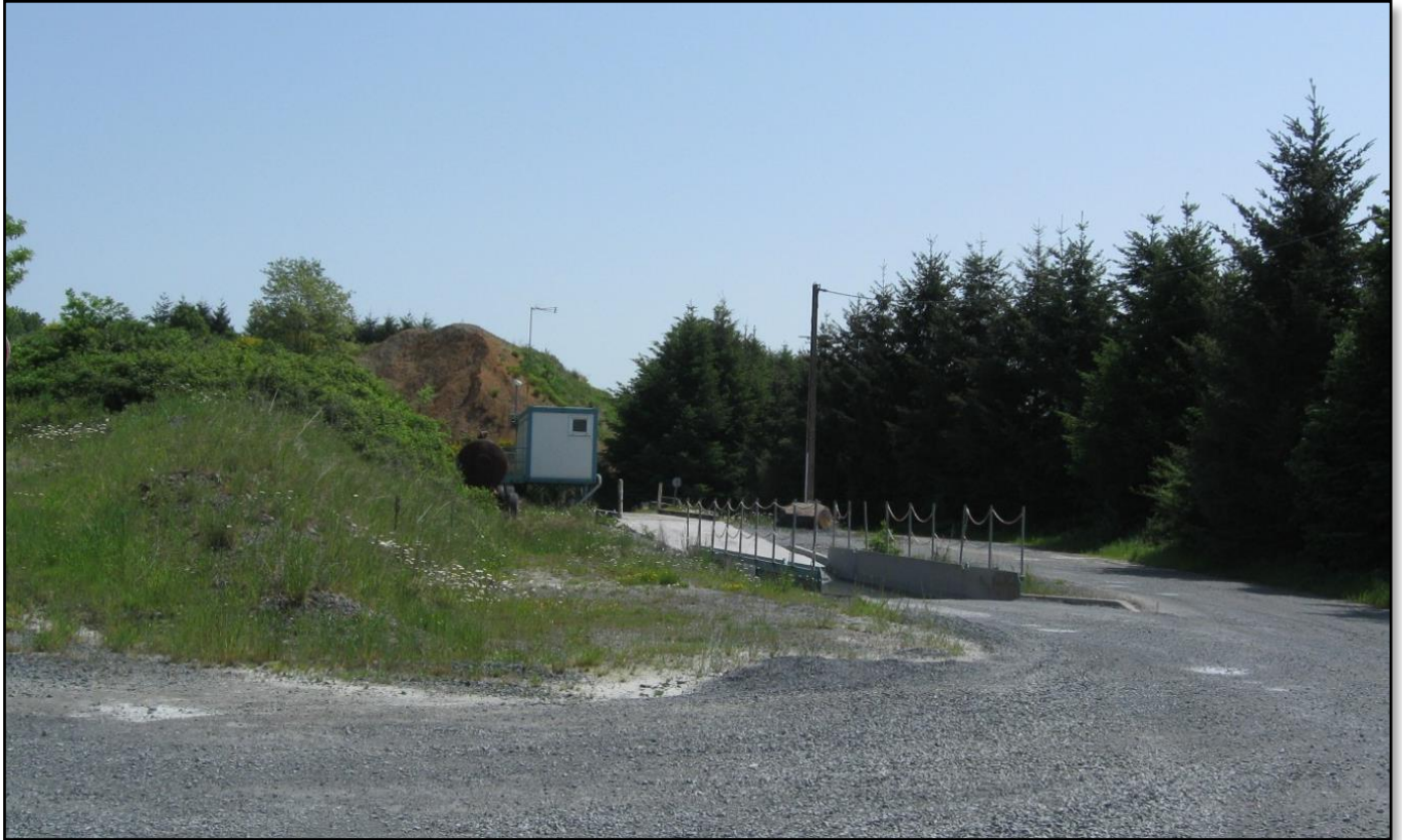
Photographie 3 : Installation de chantier – algéco, bascule et bassin de nettoyage des roues. A l'arrière-plan, le terril de stériles
