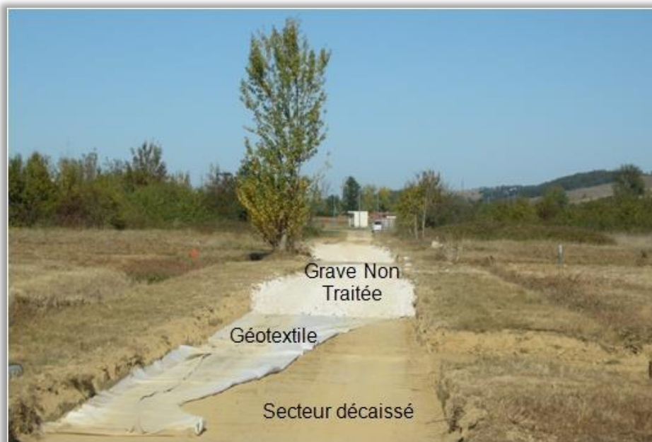
Mise en place d'une voie engins (interne) (Source : EDF Renouvelables, 2011)
