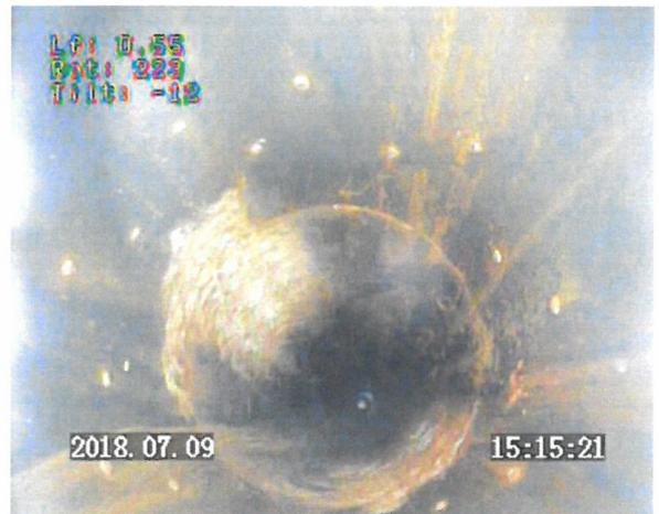
Prof 0.55 m : vue axiale tube PVC Ø185 mm / parois propre avec localement un tapissage d'oxydes de fer
