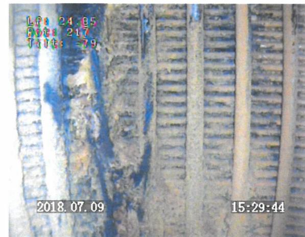
Prof 24.85 m : tube inox crépiné à fils enroulés / fentes ouvertes et massif gravillonnaire / parois sales et fentes obstruées aux abords du tube guide
