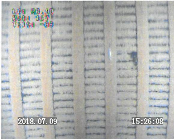
Prof 20.10 m : tube inox crépiné à fils enroulés / fentes partiellement colmatées
