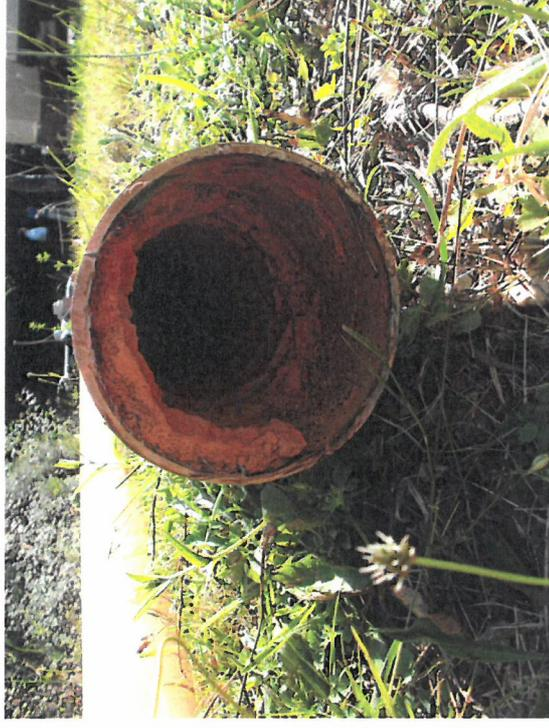
Vue du colmatage avancée de la colonne d'exhaure.
