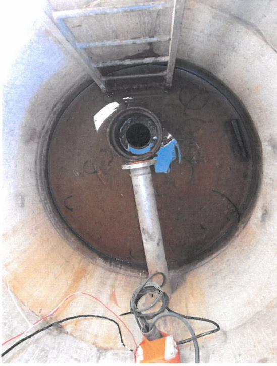
Vue du forage de Mernel, sans colonne d'exhaure, dans son cuvelage "béton".
