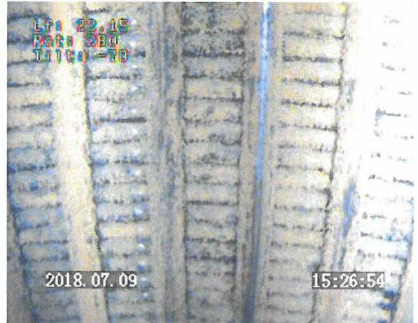
Prof 22.15 m : tube inox crépiné à fils enroulés / fentes partiellement colmatées
