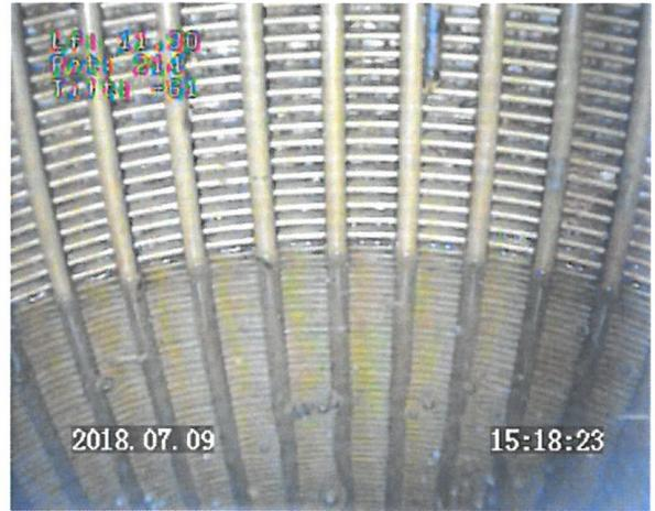
Prof 11.30 m : surface piézométrique / tube inox crépiné à fils enroulés / fentes ouvertes et massif gravillonnaire
