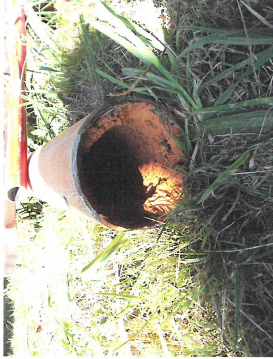
Vue du colmatage avancée de la colonne d'exhaure.
