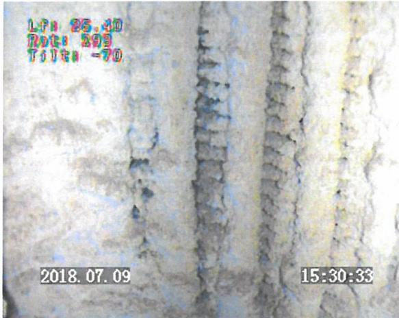
Prof 25.40 m : tube inox crêpiné à fils enroulés / fentes obstruées / dépôts importants sur les parois
