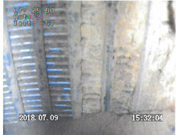
Prof 25.90 m : tube inox crêpiné à fils enroulés / fentes obstruées / dépôts importants sur les parois / base du forage rempli de dépôts
