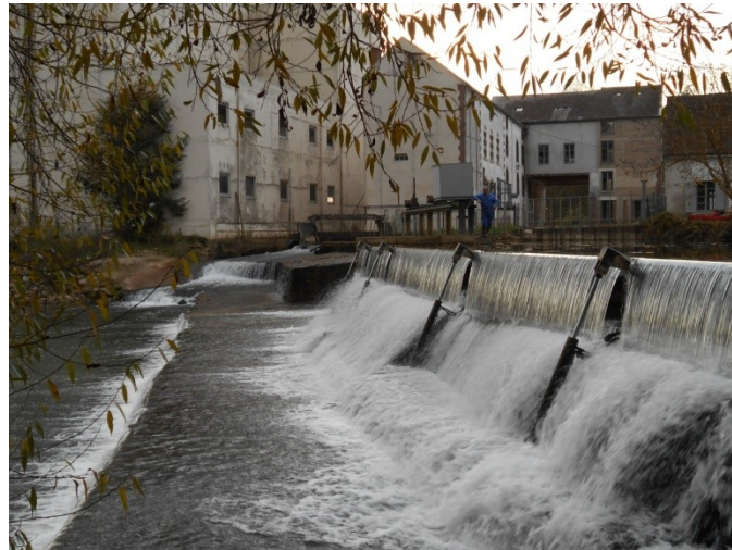
Figure 8 : Vue du seuil et des clapets (4/11/2016)
