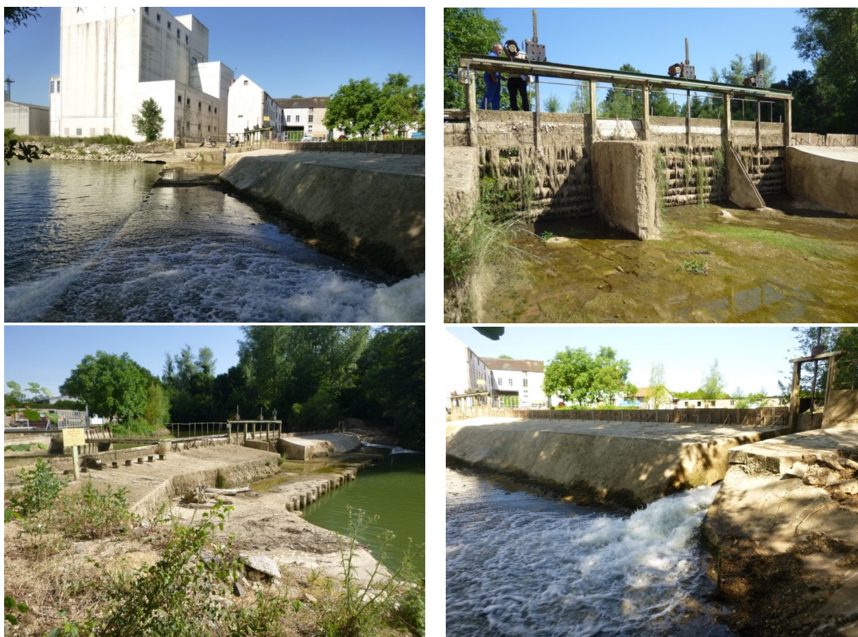
3 vannages de décharge automatisés (V1, V2, V3)
