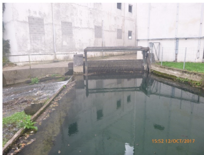
Figure 12 : Vue de la prise d'eau
