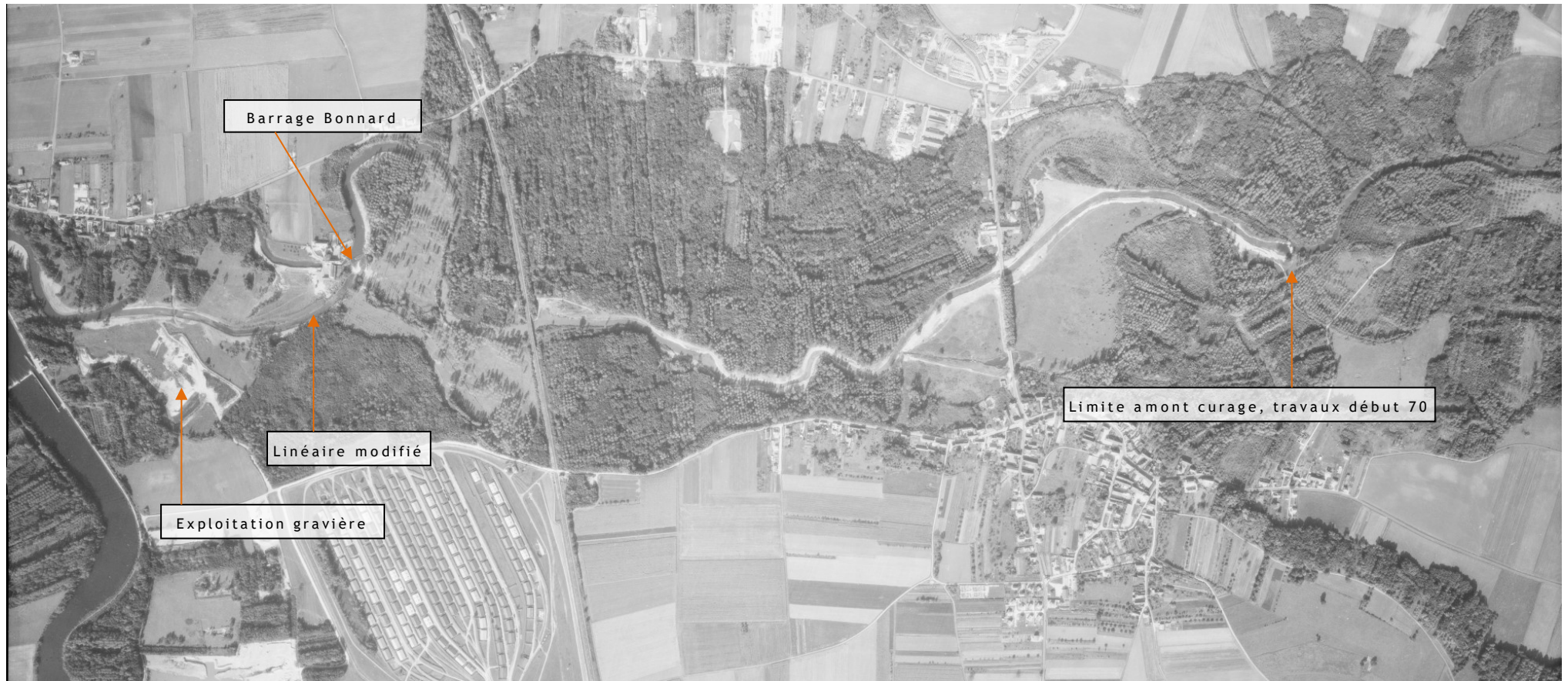
Figure 25 : Photo aérienne 10/05/1972, Travaux de curage et recalibrage du Serein
