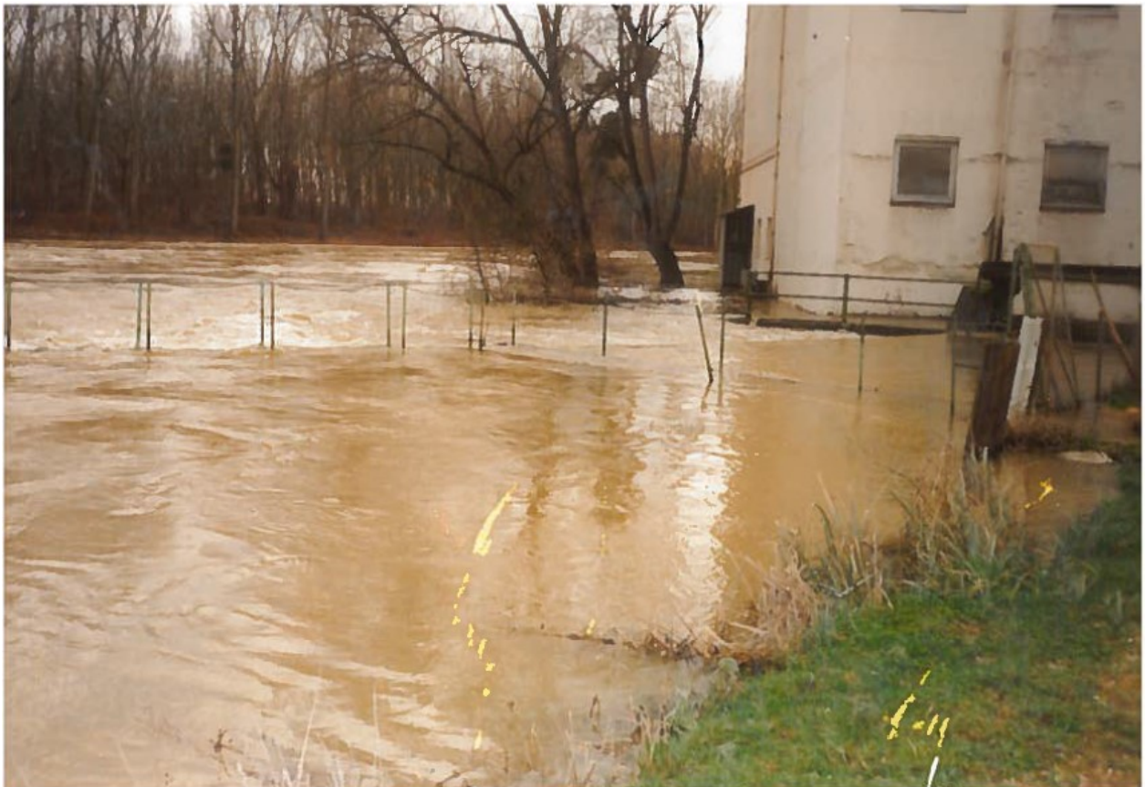
Figure 14 : Seuil quasi effacé pendant la crue de janvier 1994
