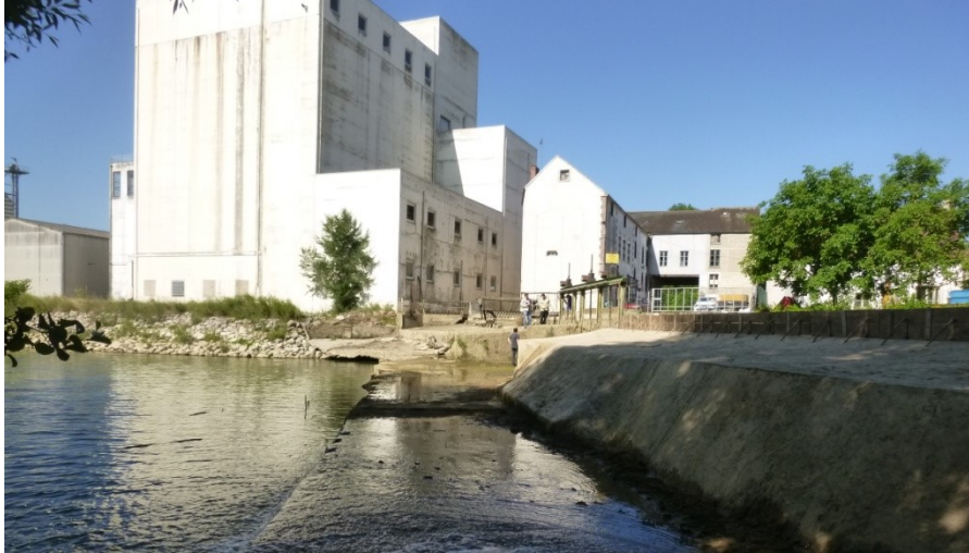
Vue des bâtiments de l'ancienne activité de minoterie
