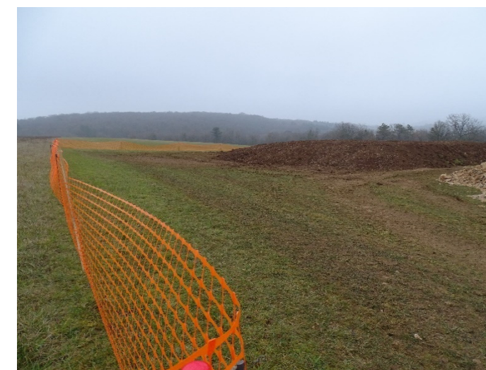
Figure 44 : Exemple de mise en défens d'une parcelle de pelouse sur une zone de travaux (Source : CAEI)
