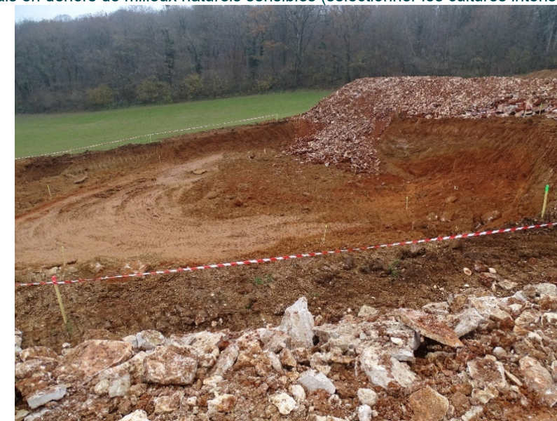
Figure 43 : Stockage de matériaux à proximité immédiate de la zone de déblais (source : CAEI)
