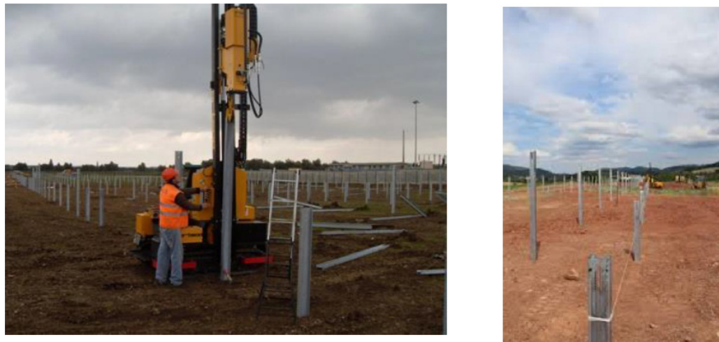
Figure 24 : Pieux battus (Source : IDESUN, 2021)
