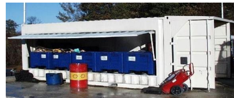
Figure 42 : Tri sélectif des déchets de chantier (Source : Biotope)
