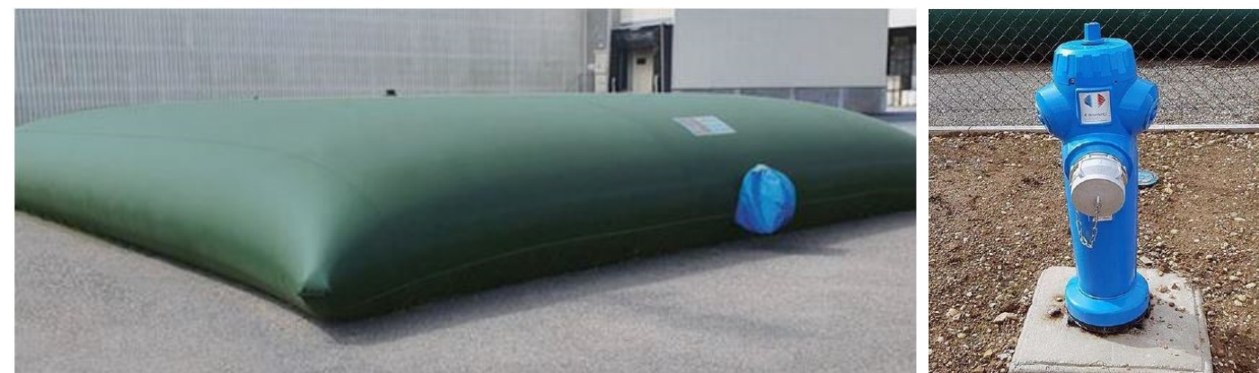
Figure 35 : Citerne souple et bouche à aspiration
