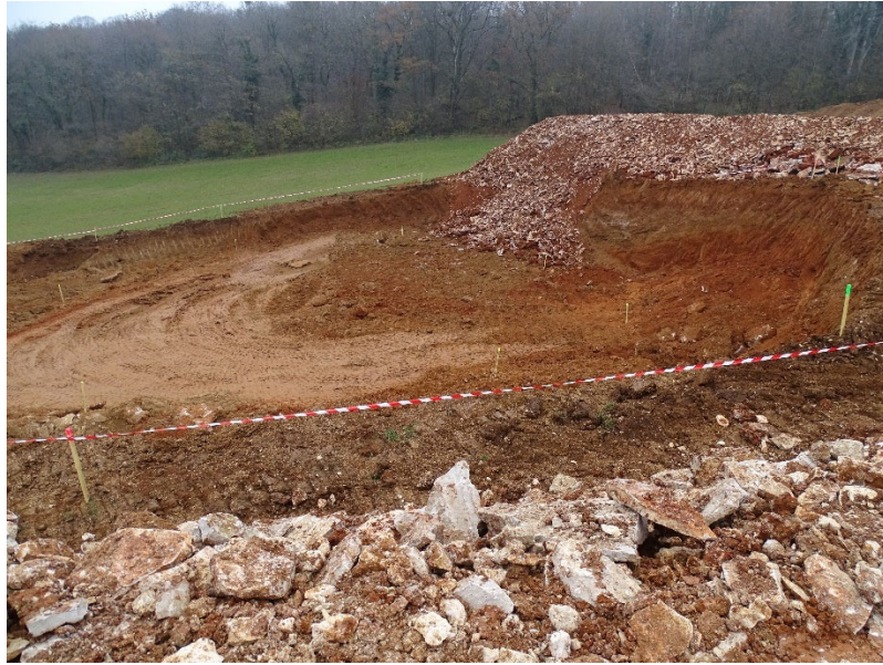
Stockage de matériaux à proximité immédiate de la zone de déblais (source : CAEI)
