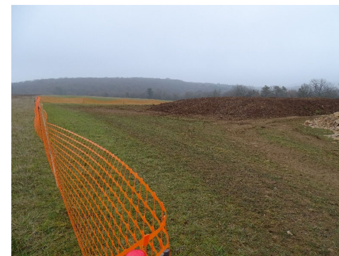
Exemple de mise en défens d'une parcelle de pelouse sur une zone de travaux (source : CAEI)
