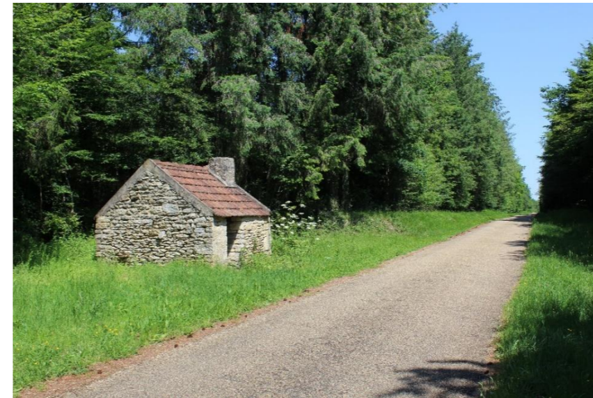
Figure 20 : Route traversant la forêt
