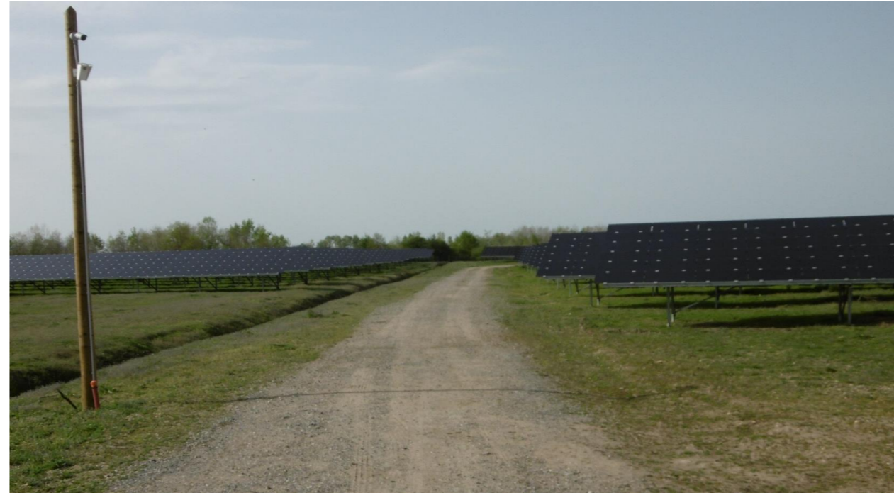
Figure 82 : Exemple de chemin interne de parc photovoltaïque récemment aménagé (Yzeure 03) (source : Corydalis)
