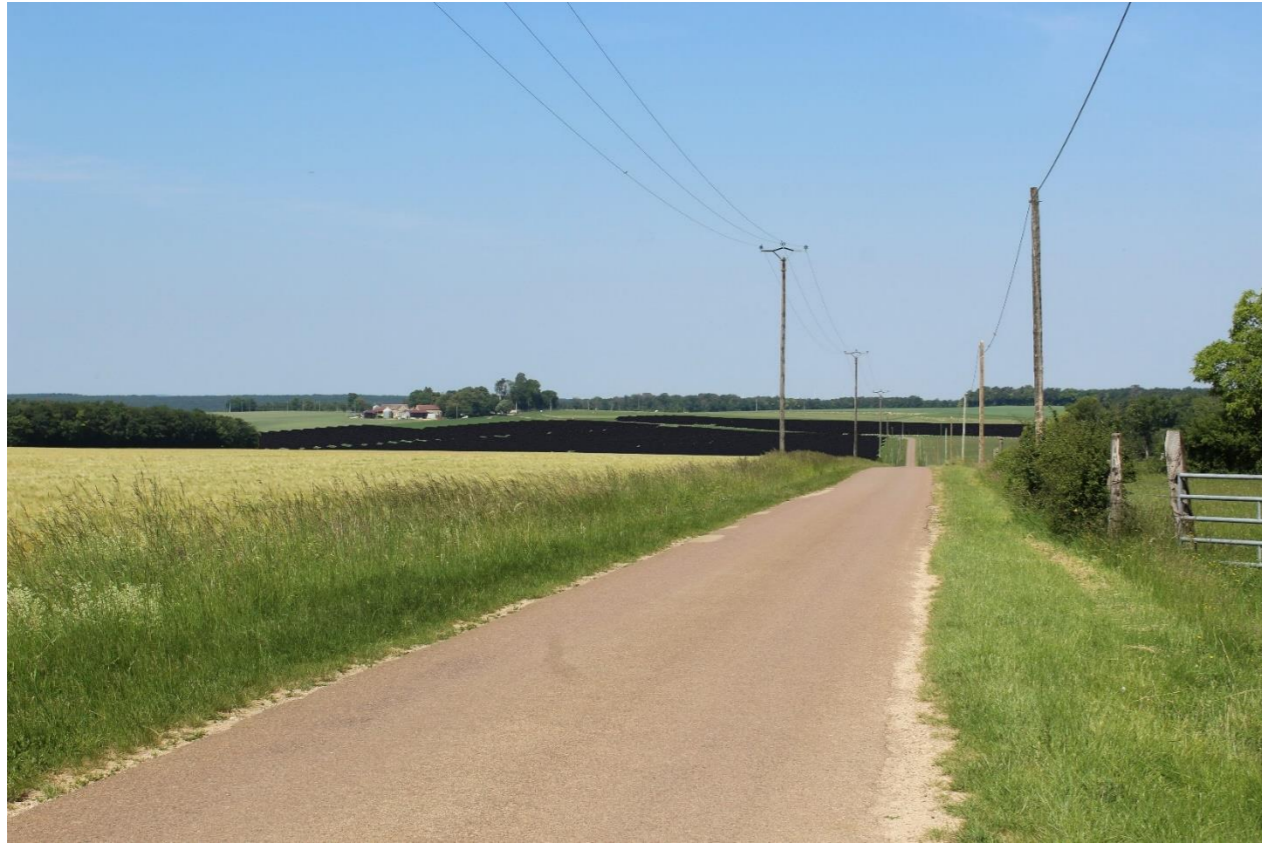
Figure 88 : Vue 4 - Simulation du projet retenu depuis la sortie des Souillats (RD401) (source : Corydalis)
