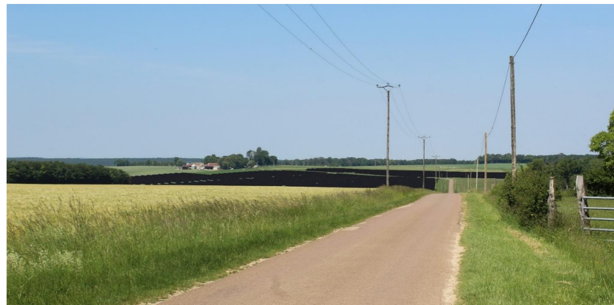
Figure 7 : Vue 4 - Simulation du projet retenu depuis la sortie des Souillats (RD401) (source : Corydalis)
