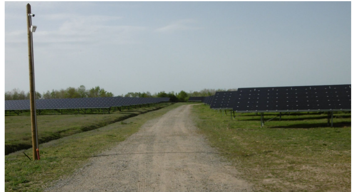
Figure 46 : Exemple de chemin interne de parc photovoltaïque récemment aménagé (Yzeure 03).
