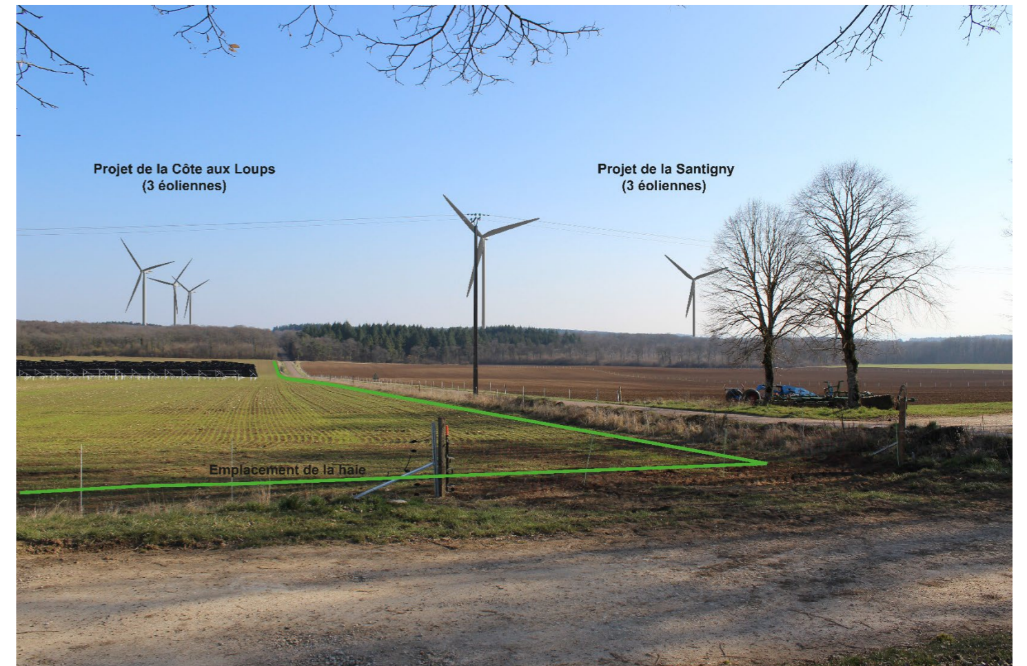
Figure 60 : Projet éolien de Pisy (à gauche le long de la RD101) et de Santigny à droite, en vert emplacement de la haie prévue
