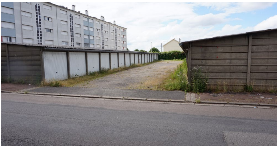
Malgré un faible usage de la voiture sur la quartier de nombreux espaces de garages sont présents. Ces typologies de bâtiments sont en rupture avec l'existant et n'apportent aucunes qualités urbaines.
