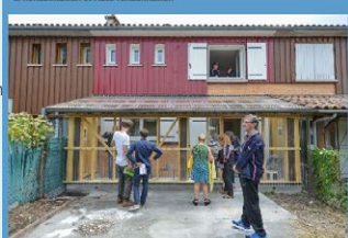
Aquitains : auto-réhabilitation accompagnée de 245 maisons - cité Claveau
