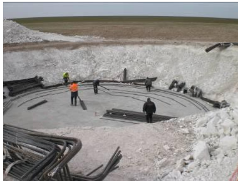
Photo 67 : Exemple de fondations à remettre en état
