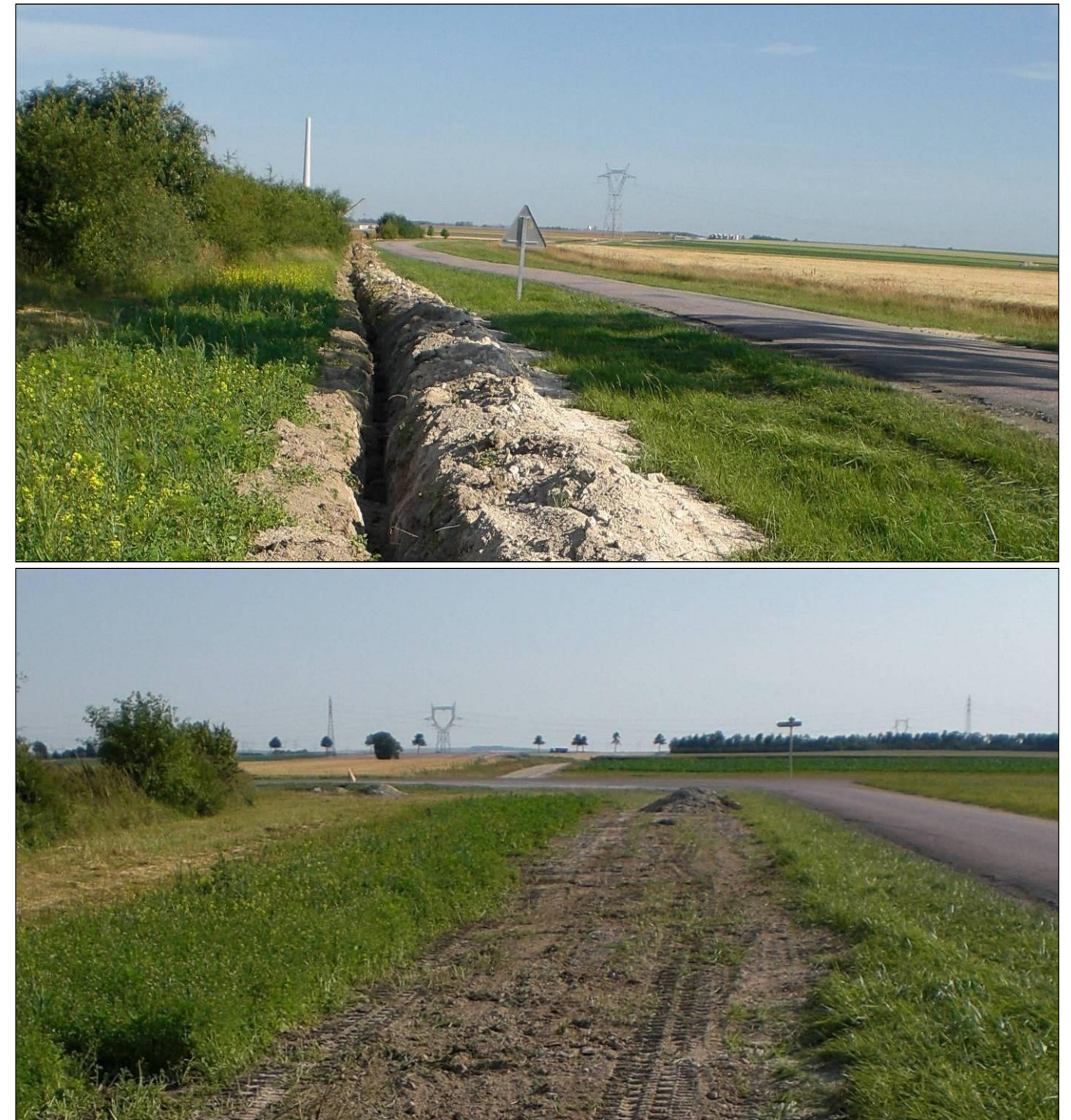
Photo 144 : Rebouchage de tranchée après passage des câbles électriques (Source : BE JC)
