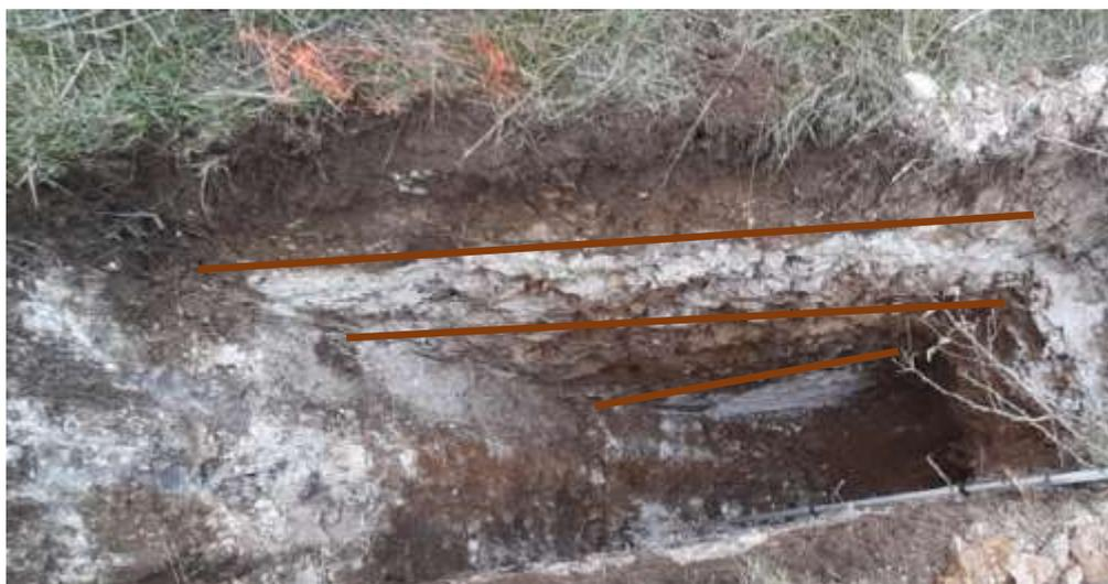
Figure 46 : Remblais mis en œuvre par couche en F5
