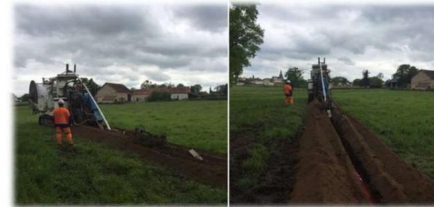
Figure 1 Exemple de chantier d'enfouissement d'un réseau électrique en terres agricoles (source : Cegelec infra)
