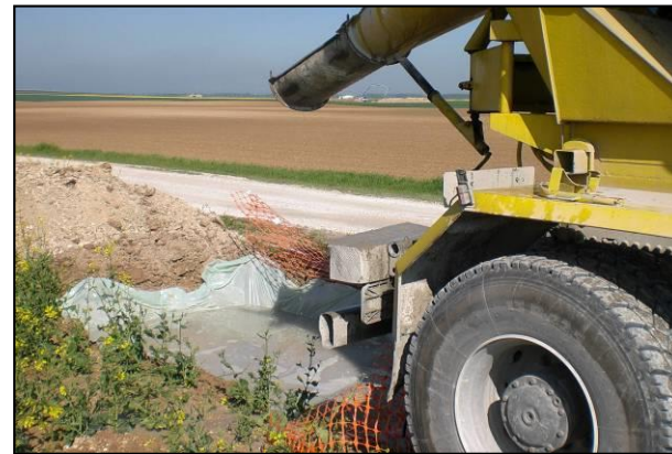
Photo 67 : Exemple de récupération des laitances de béton (Source : BE Jacquel et Chatillon)
