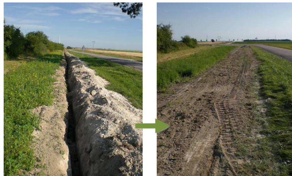
Photo 37 : Rebouchage de tranchée après passage des câbles électriques (Source : BE Jacquel et Chatillon)
