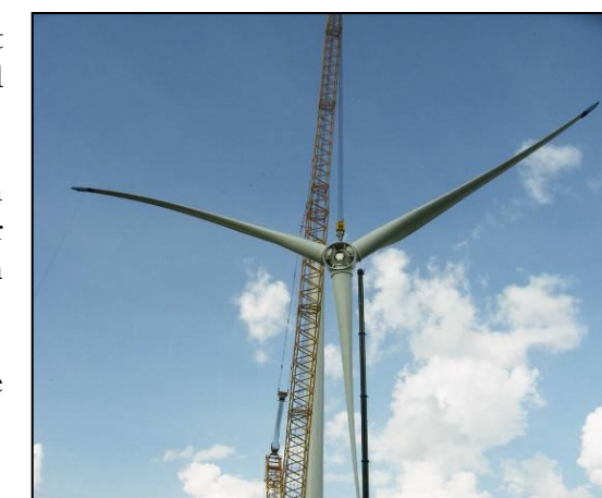
Photo 26 : Exemple de montage d'un rotor d'éolienne (Source : Bureau d'études Jacquel et Chatillon)
