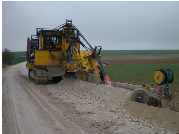
Photo 36 : Pose mécanisée de câbles électriques (Source : BE Jacquel et Chatillon)
