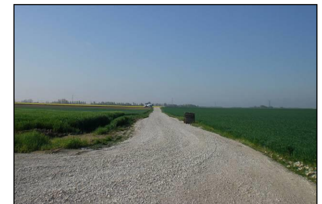
Photo 31 : Exemple de chemin d'accès après renforcement (Source : BE Jacquel et Chatillon)
