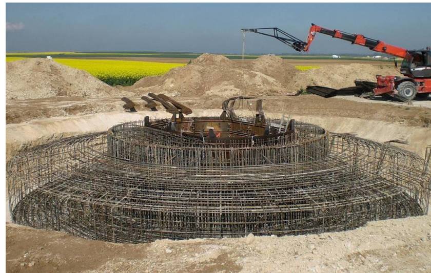
Photo 33 : Exemple de maillage d'acier d'armature pour fondation d'éoliennes de type massif poids (Source : BE Jacquel et Chatillon)
