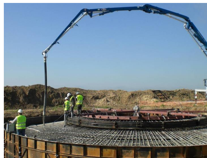
Photo 34 : Exemple de coulage du béton de fondation d'éolienne (Source : BE Jacquel et Chatillon)
