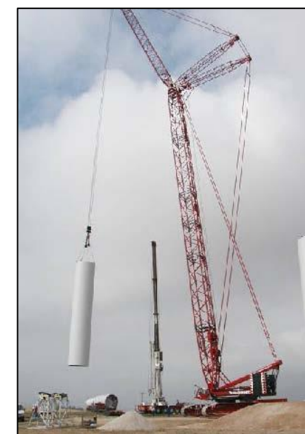
Photo 25 : Exemple d'assemblage d'un mât d'éolienne (Source : BE Jacquel et Chatillon)
