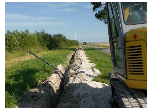
Photo 35 : Pose de câbles électriques et réalisation de tranchée à la pelle mécanique (Source : BE Jacquiel et Chatillon)
