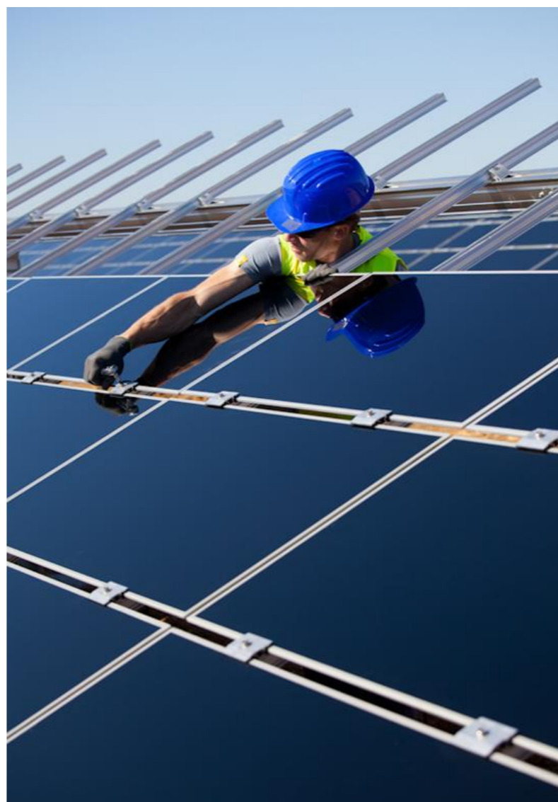
Remplacement de module (crédit photo EDF Renewables)
