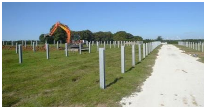
Travaux de montage des supports des modules (crédit photo : Ectare)
