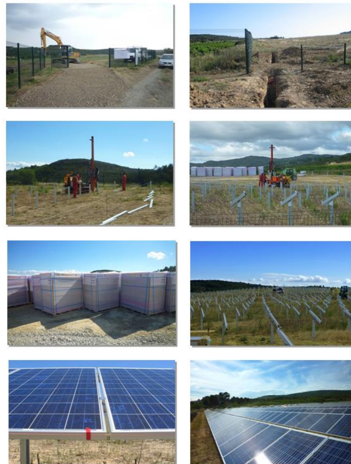
Figure 35. Présentation des différentes étapes du chantier (Source : EDF Renouvelables France)
