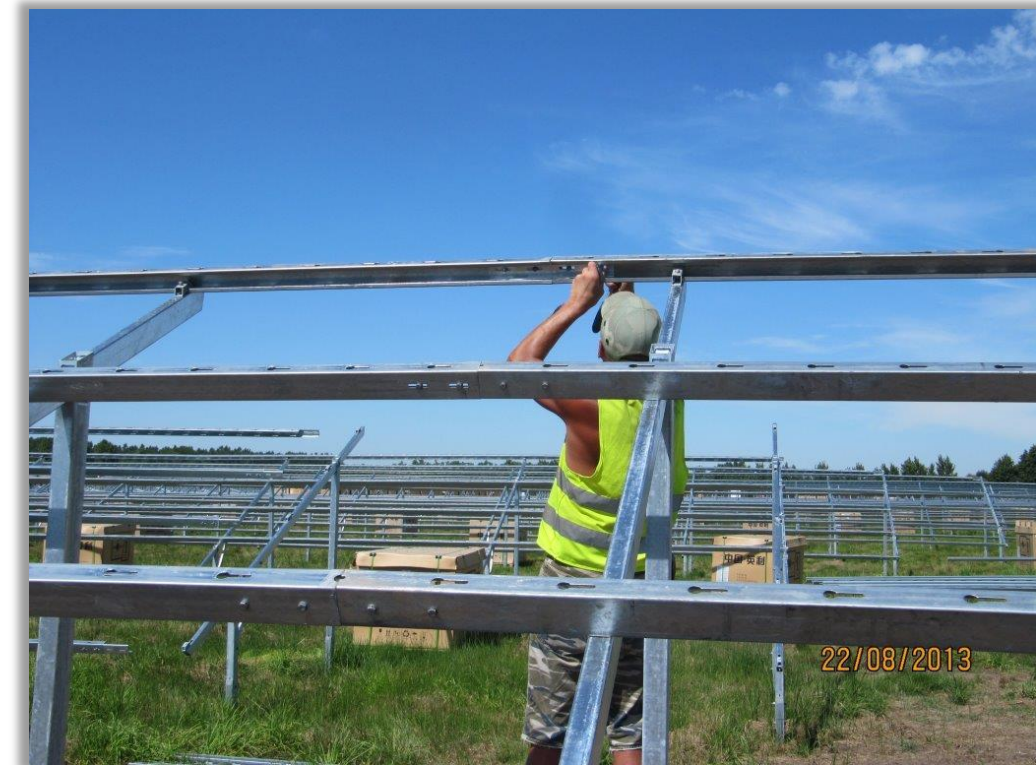
Figure 14. Systèmes de fixation pour installation photovoltaïque
