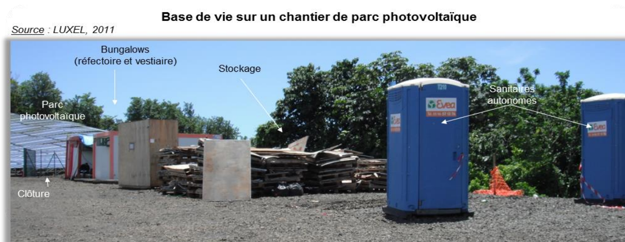
Figure 135. Illustration d'une base vie de chantier
