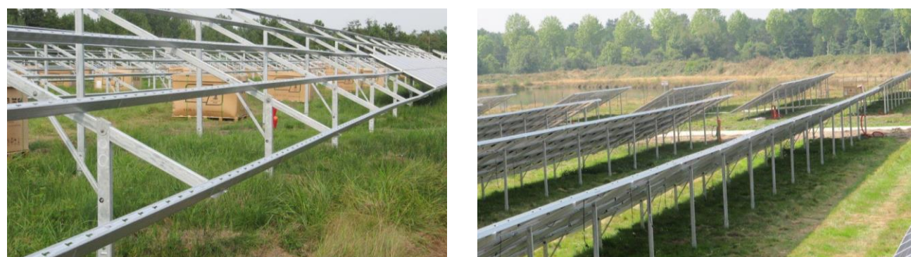
Impacts faibles sur un terrain humide suite à la pose des structures et modules - Source : Luxel, 2013
