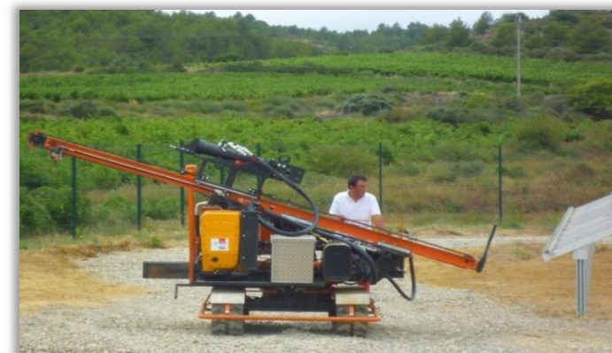
Machine de battage de pieux
