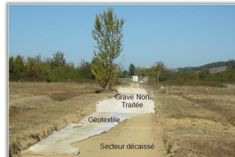
Figure 30. Mise en place d'une voie engins (interne)
