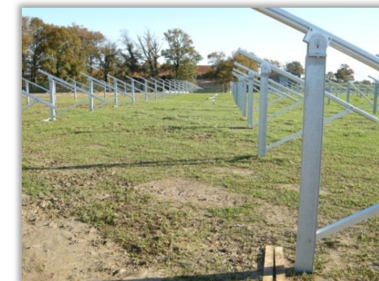
Structures prêtes à recevoir des modules
