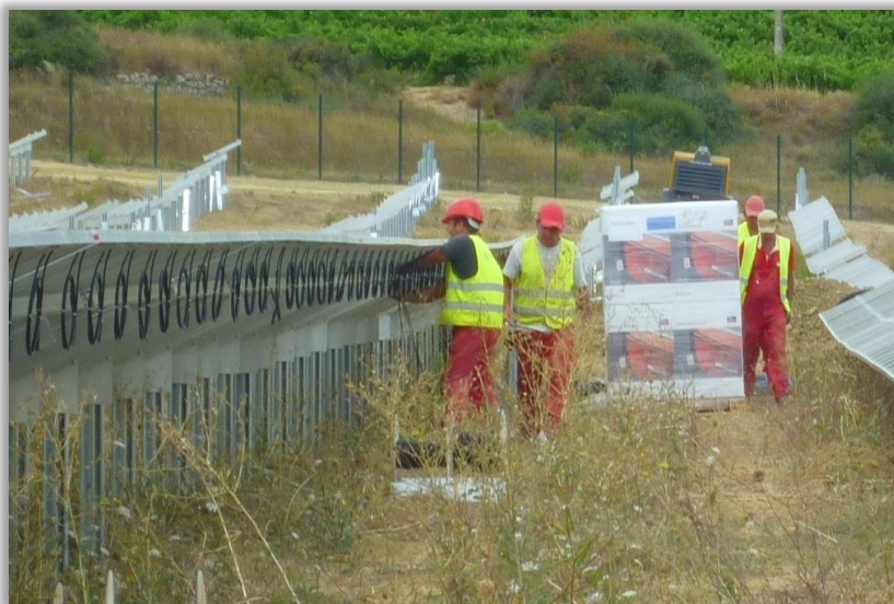
Figure 22. Câblage et interconnexion des modules photovoltaïques
