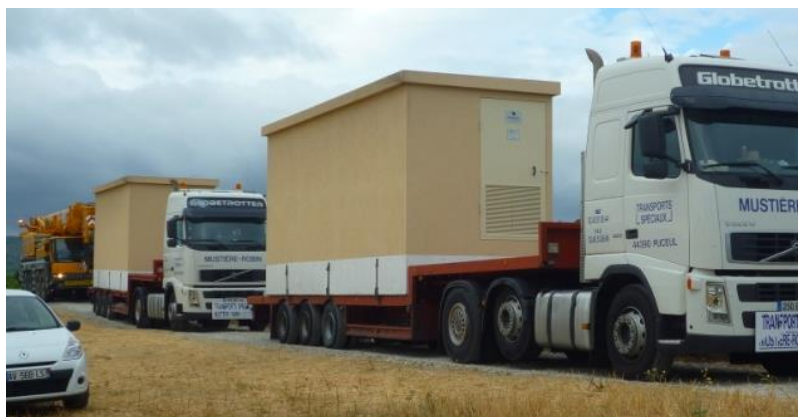
Figure 31. Convoi exceptionnel : Transport des locaux techniques
