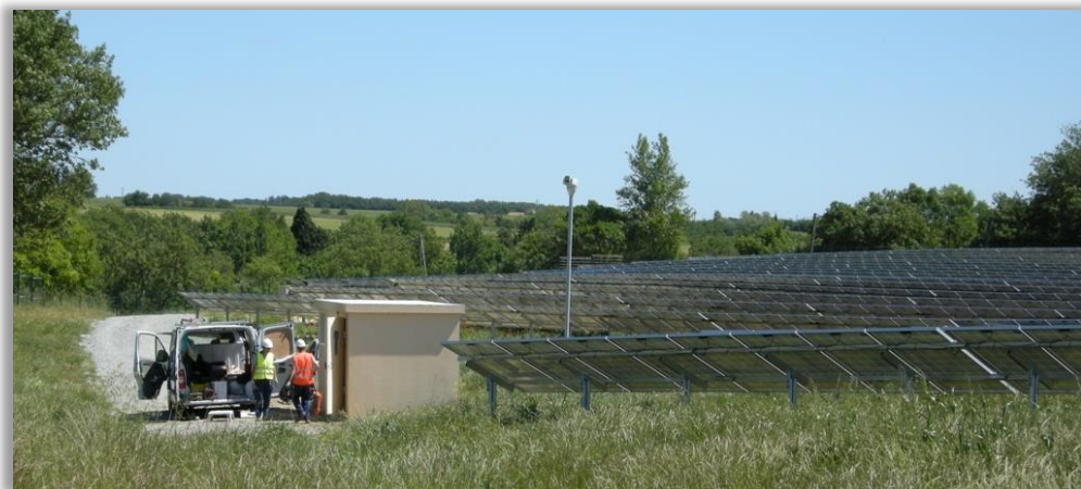
Figure 36. Opération de maintenance
