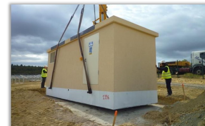
Figure 34. Schéma de dépose des postes préfabriqués - Source : Transfix et de pose de poste préfabriqué
