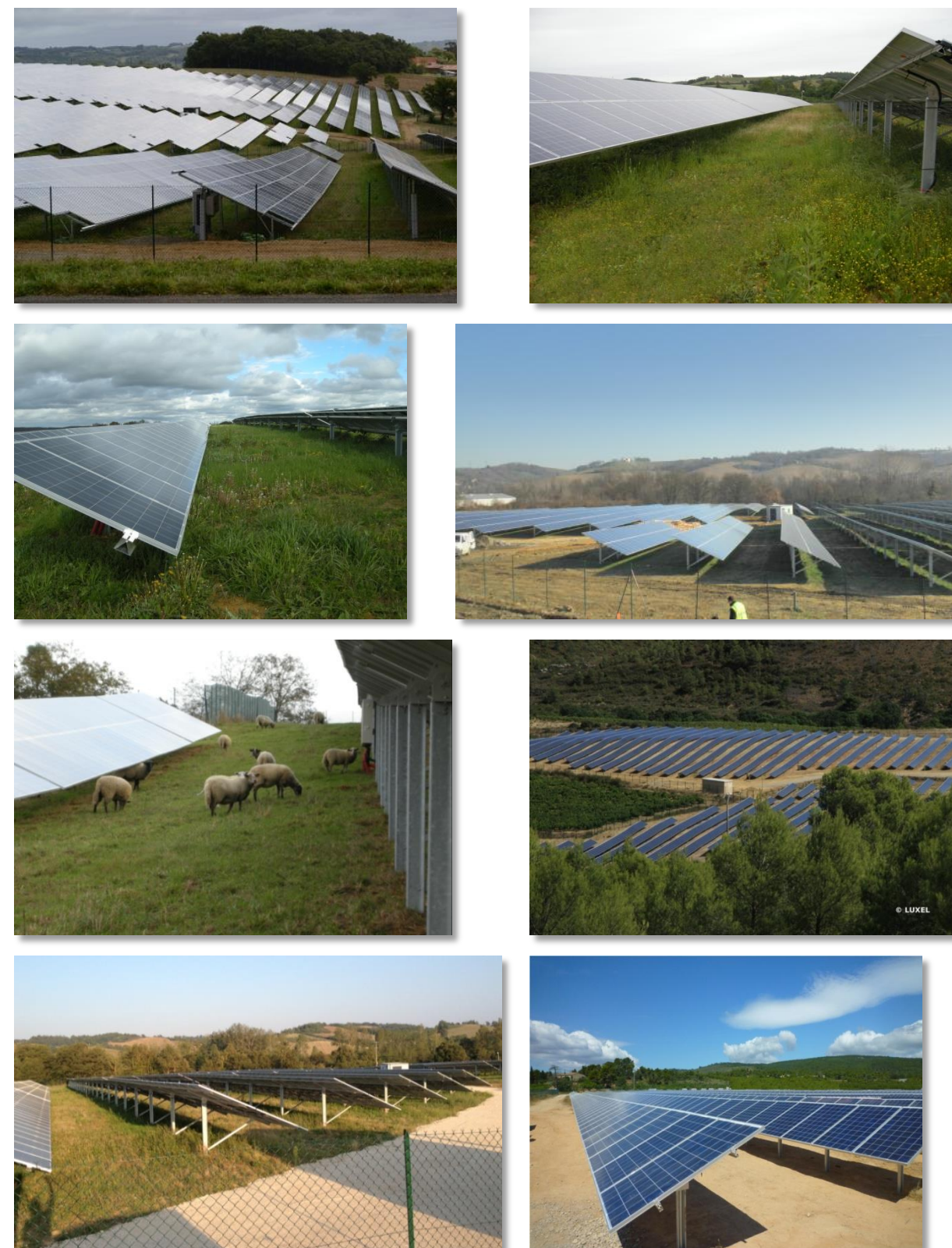
Figure 11. Illustration de parcs photovoltaïques en France – Source : EDF Renouvelables France
