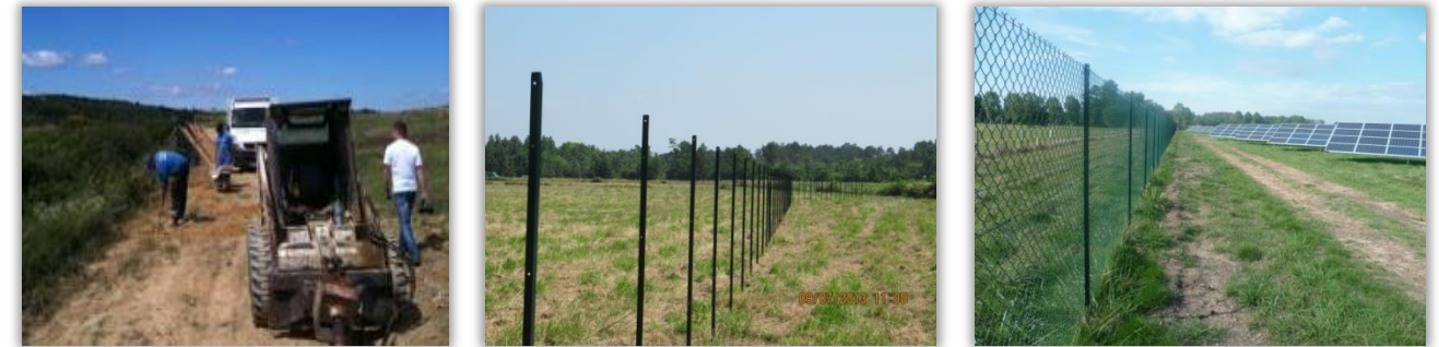
Figure 26. Mixe en place de la clôture : pose des ancrages, des piquets et du maillage
