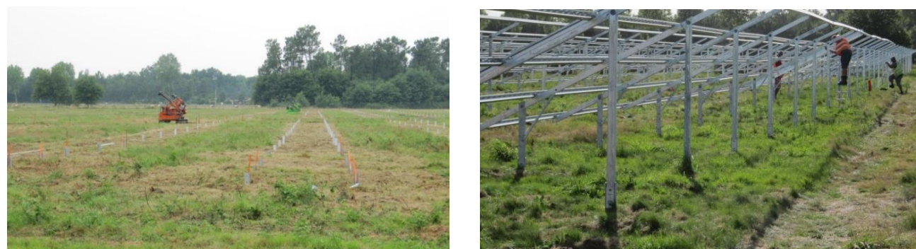
Un faible impact sur le sol et le couvert végétal lors de l'ancrage des pieux et pose de structures (Parc de Saint-Aubin de Blaye) – Source : Luxel, 2013
