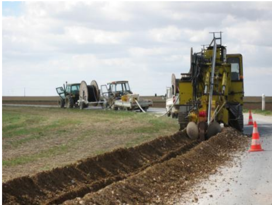
Figure 136. Illustration des travaux de raccordement réalisés par ENEDIS (source : EDF Renouvelables)
