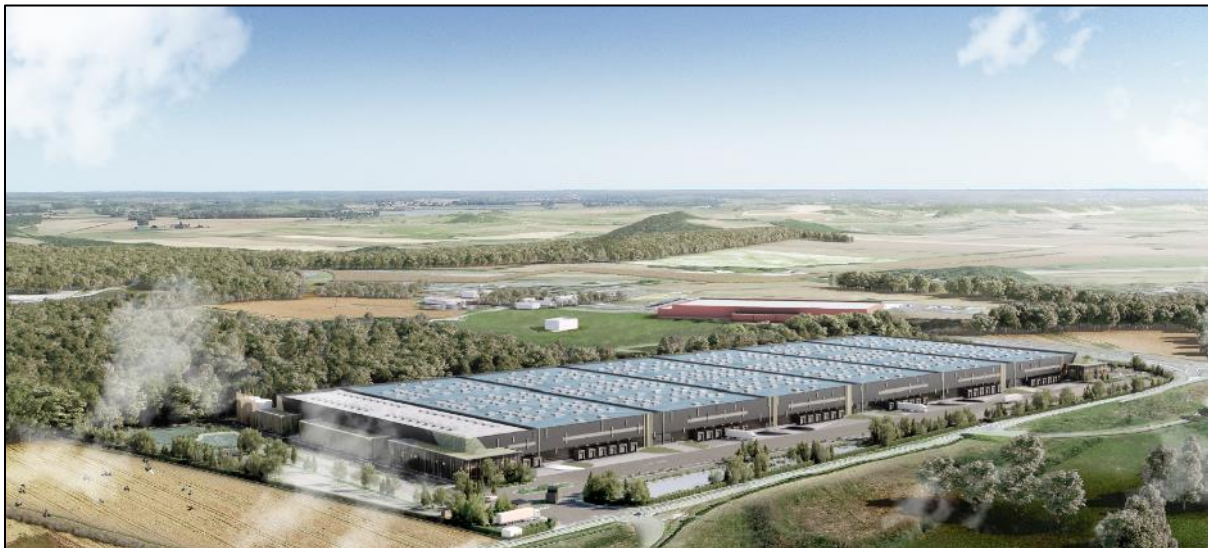
Figure 20 : Insertion du projet dans son environnement
