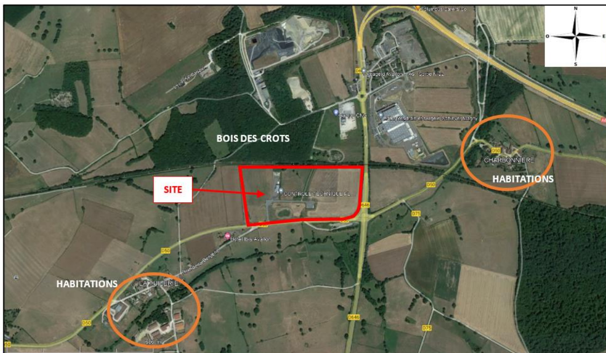
Figure 2 : Vue aérienne de la zone d'étude
