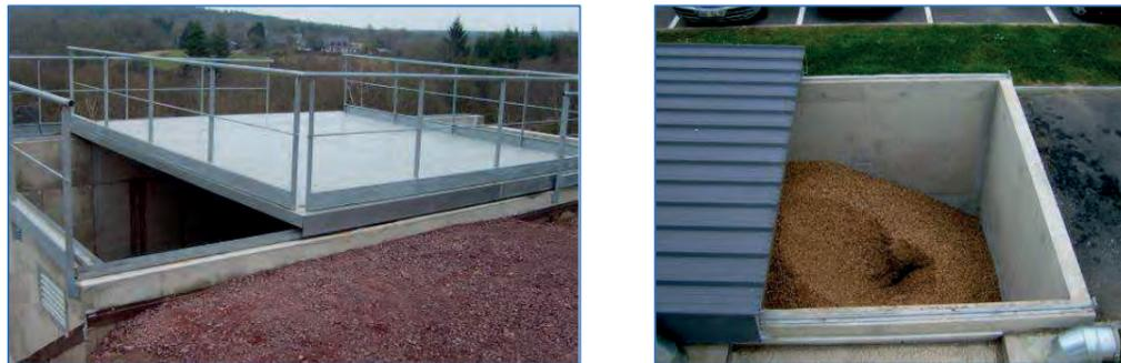
Figure 66 : Silos enterrés
