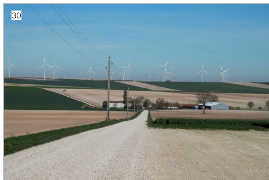
La Ferme de la Noue à proximité de la zone de projet (en arrière-plan, les Parcs de Quatre Vallées I et III à environ 3,5 km)
