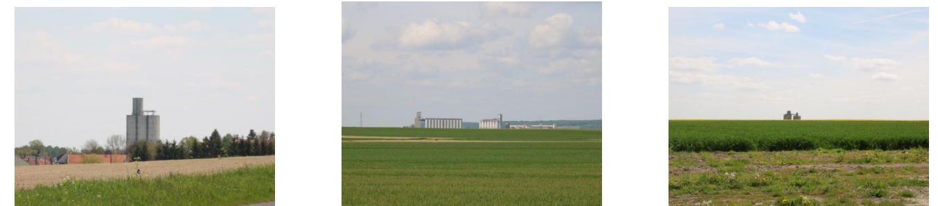
Figure 46 : Silo de Normée (gauche), silo de Coligny (centre), silo de Lenbarée (droite)(Source : BE JC)
