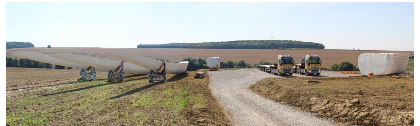
Eléments d'éoliennes avant montage (Source : Ora environnement)
