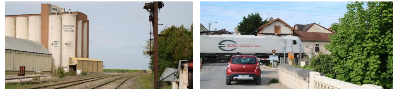
Figure 57 : Ligne de Coolus à Sens (gauche) et ligne de la Vallée de la Marne (droite)(Source : BE JC)
