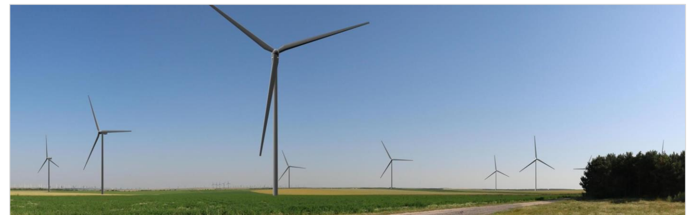
Figure 107 : Vue filaire et photomontage n°1, depuis la route communale entre Cheniers et la D977, à 240 m du projet éolien, angle de 120° (Source : BE JC)
