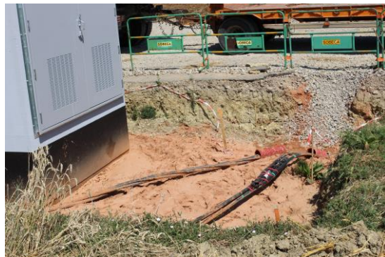
Câbles souterrains reliant les éoliennes au poste de livraison avant enfouissement (Source : Ora environnement)
