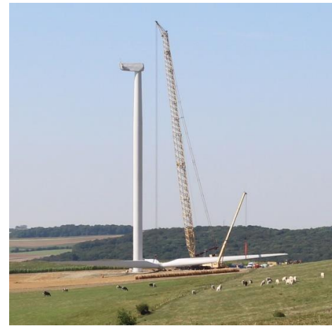
Rotor assemblé au sol avant levage (Source : Ora environnement)
