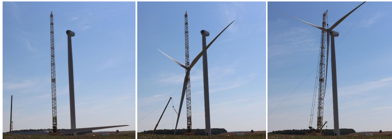
Etapes du montage du rotor d'éolienne (Source : Ora environnement)
