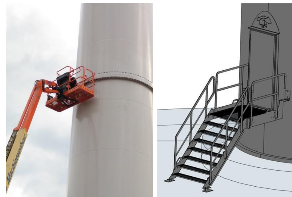
Figure 127 : Bride extérieure pouvant servir de perchoir, absent pour le modèle N149TS105 retenu pour le projet (à gauche) et cache et la lampe extérieure ne seront pas installés sur les machines du projet (à droite)(Source : IEA)
