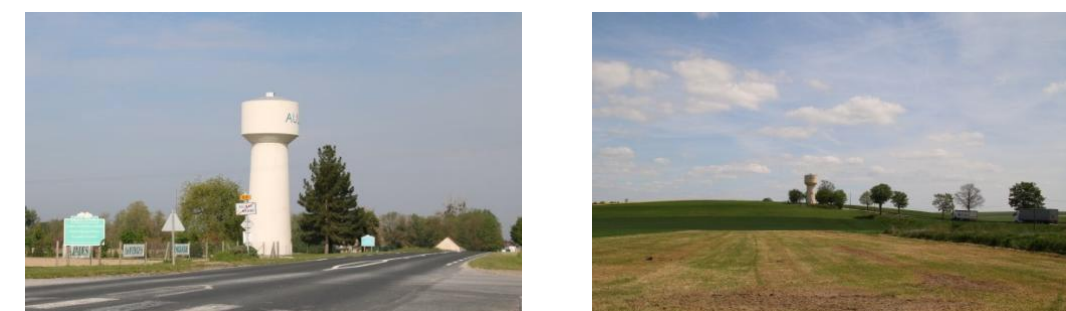
Figure 47 : Château d'eau d'Aulnay-sur-Marne (gauche) et château d'eau de Soudé (droite)(Source : BE JC)
