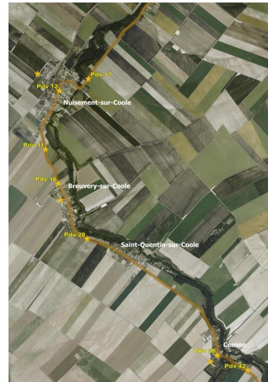
Figure 65 : Vue aérienne de la route D4 (Source : BE JC, d'après IGN)
