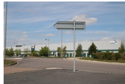
Photo 37 : Entrepôts de fret dans la zone de l'aéroport Paris-Vatry (Source BE JC)
