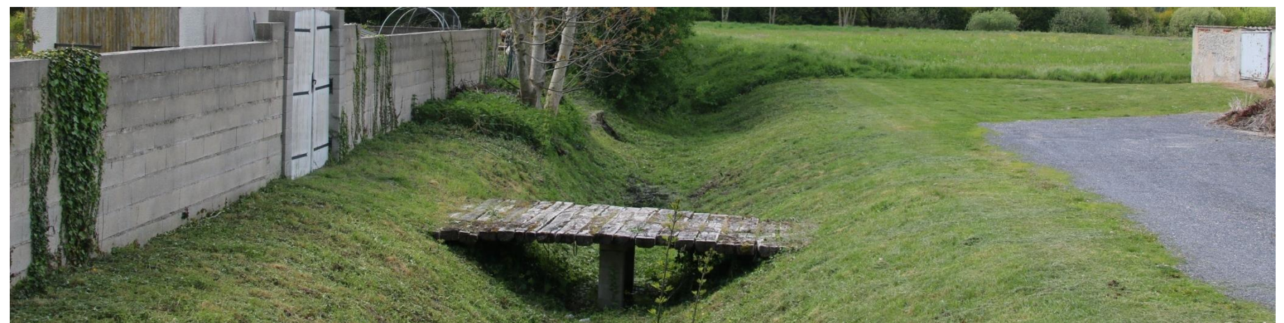
Photo 77 : Source du Petit Morin à Morains-le-Petit (Source BE JC)
