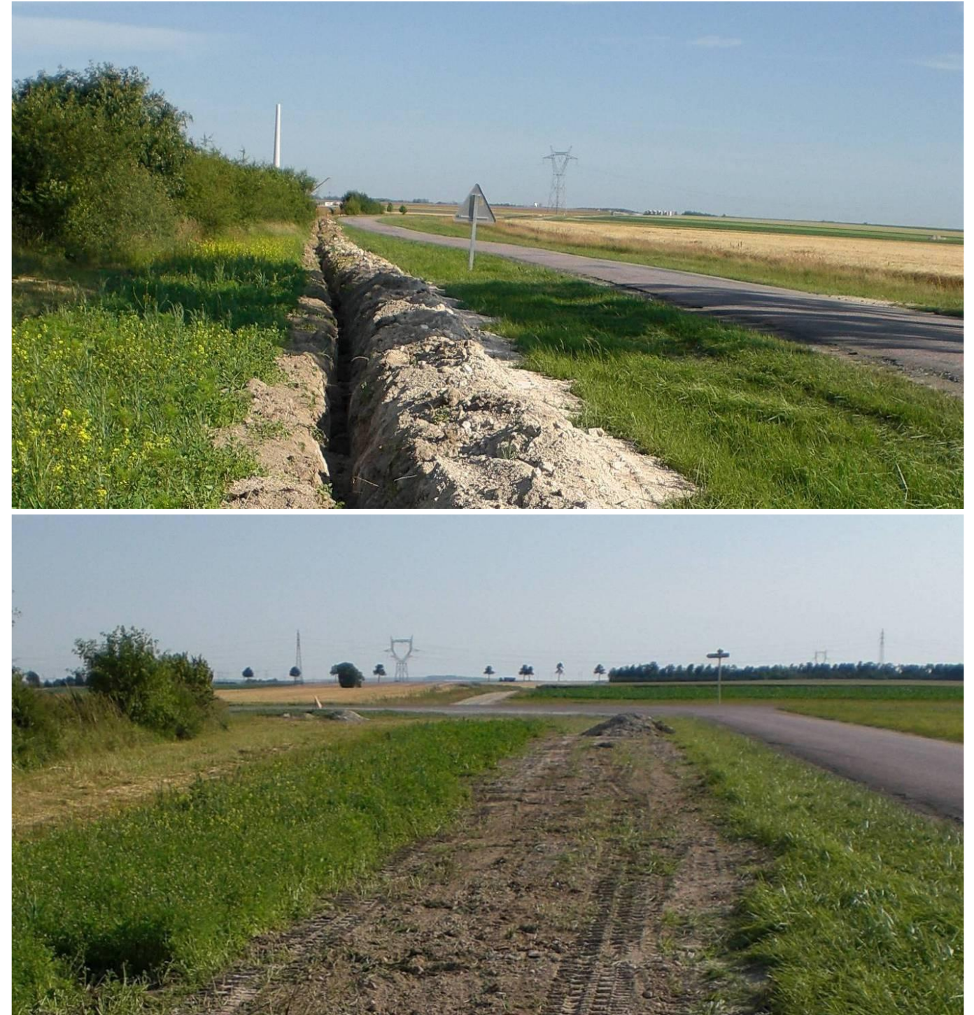
Photos 202 : Rebouchage de tranchée après passage des câbles électriques (Source : BE JC)
