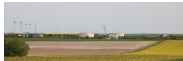
Photo 31 : Dépôt d'hydrocarbure le long de la D977 (Source BE JC)
