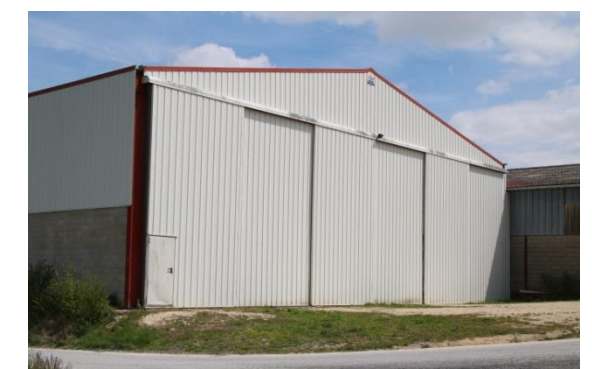
Photo 17 : Hangar de Sommesous (Source BE JC)
