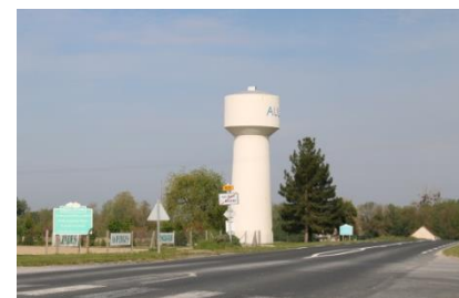
Photo 27 : Château d'eau d'Aulnay-sur-Marne, depuis la D3 (Source BE JC)
