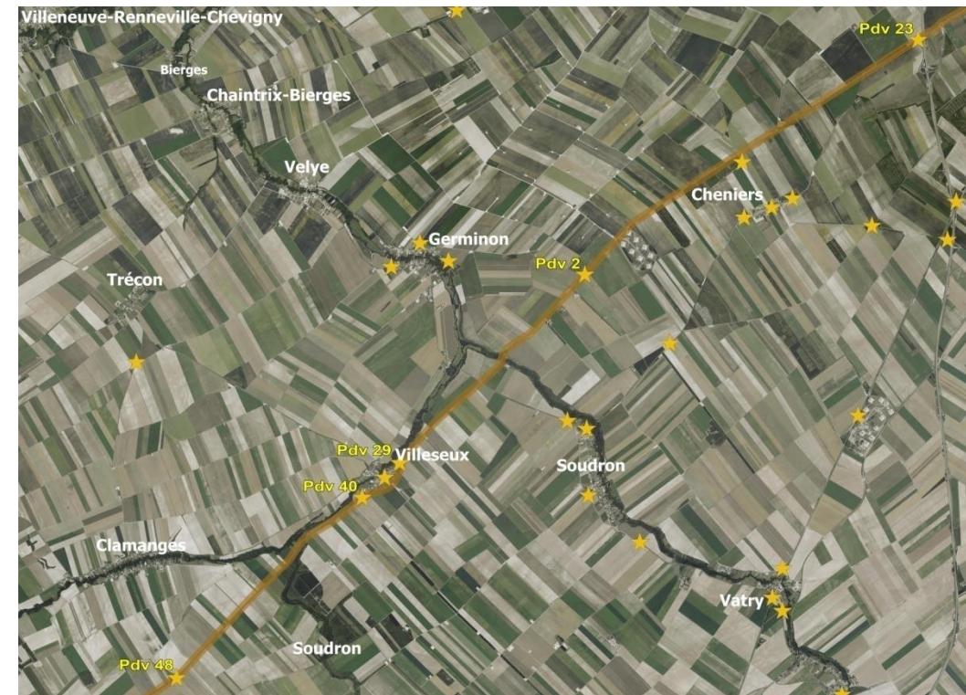
Figure 64 : Vue aérienne de la route D5 (Source : BE JC, d'après IGN)
