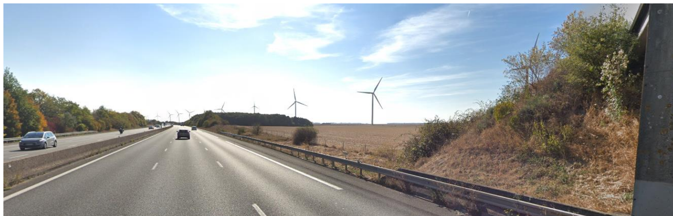
Photo 48 : Parc éolien du Chemin d'Ablis, le long de l'A10, dans l'Eure-et-Loir (Source : Google Streetview)
