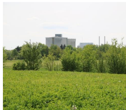
Photo 20 : Féculerie de pommes-de-terre d'Haussimont, depuis le village (Source BE JC)
