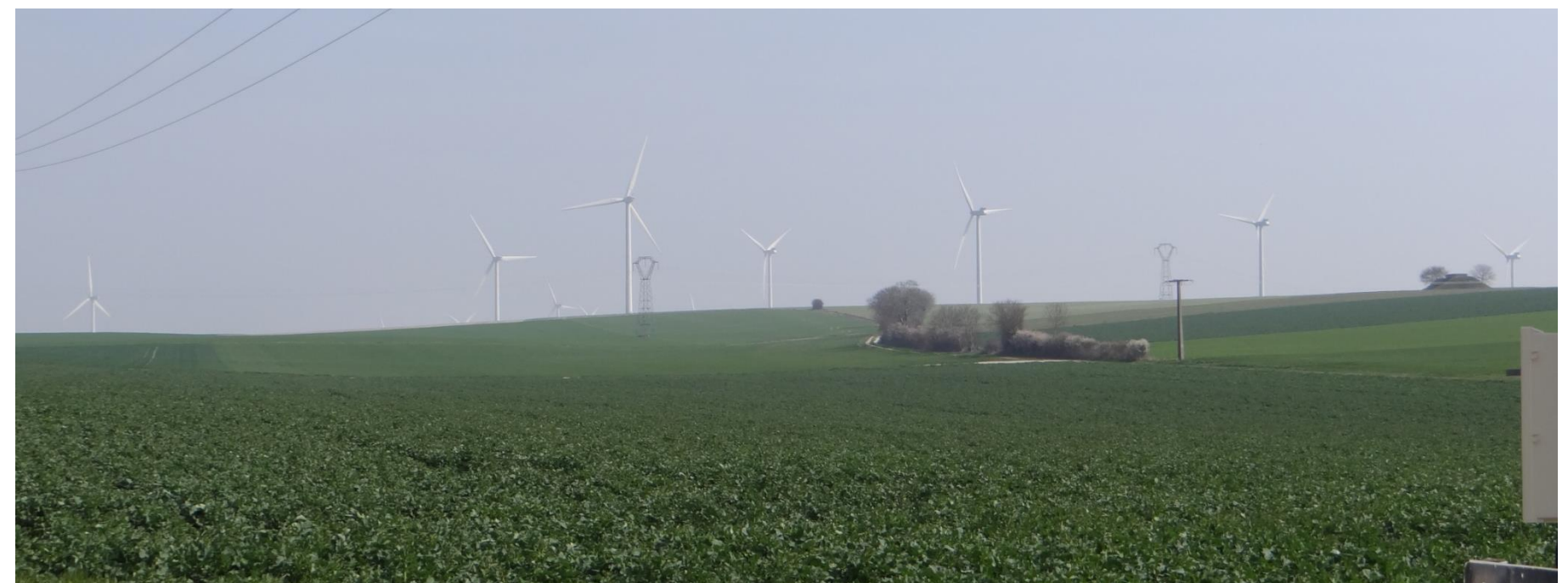
Photo 82 : Implantation éolienne dans les ondulations du relief de la Côte de Champagne (Source BE JC)
