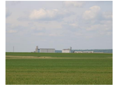
Photo 23 : Silo de Coligny, depuis la D9 (Source BE JC)
