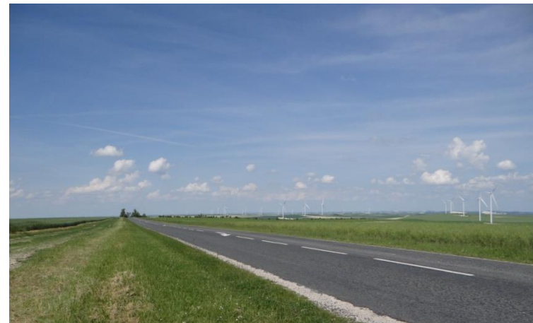
Photo 98 : Vue plongeante depuis la D4 entre Coole et Sompuis (Source BE JC)
