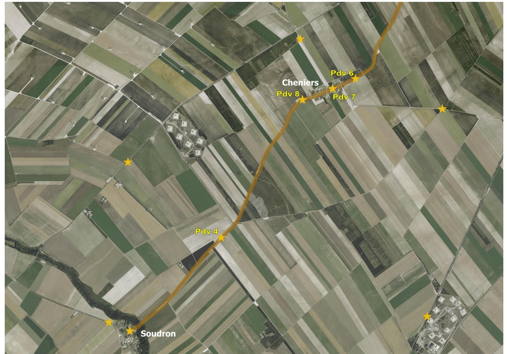
Figure 61 : Vue aérienne de la route D83 (Source : BE JC, d'après IGN)
