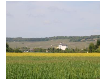
Photo 22 : Silo de Vertus, depuis la D37 entre Voivreux et Vertus (Source BE JC)
