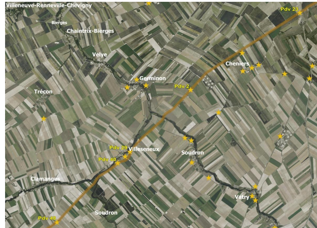
Figure 60 : Vue aérienne de la route D5 (Source : BE JC, d'après IGN)
