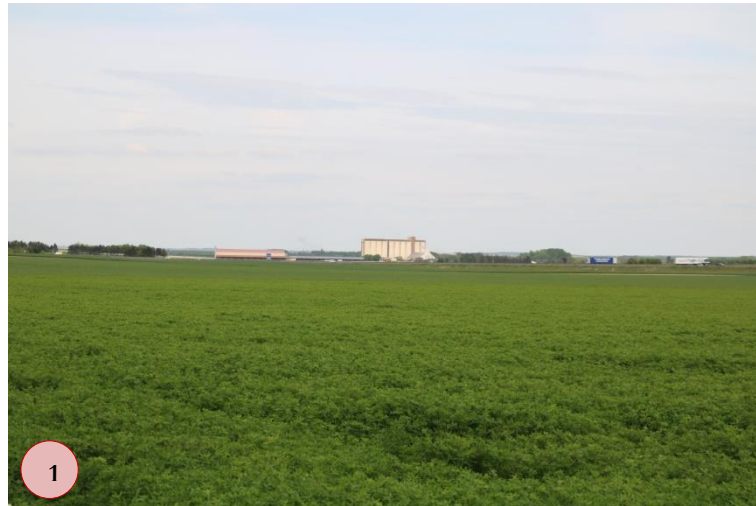
Photo 114 : Vue sur l'A26 et le silo de Nuisement-sur-Cooles depuis la D977 (Source BE JC)
