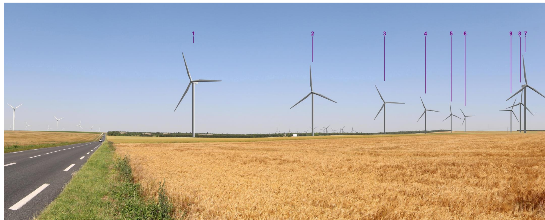
Photo 131 : Variante 1, depuis le point de vue n°2, angle de 120° (Source : BE JC)
