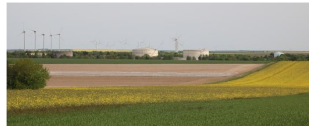
Photo 31 : Dépôt d'hydrocarbure le long de la D977 (Source BE JC)
