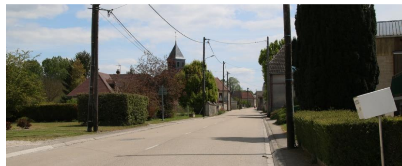
Photo 46 : Axe traversant du « village-rue » de Normée (Source BE JC)
