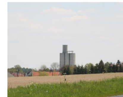
Photo 25 : Silo de Normée, depuis la D18 (Source BE JC)
