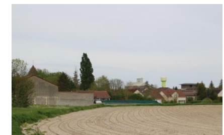
Photo 29 : Château d'eau de Thibie, depuis l'entrée ouest du village (Source BE JC)
