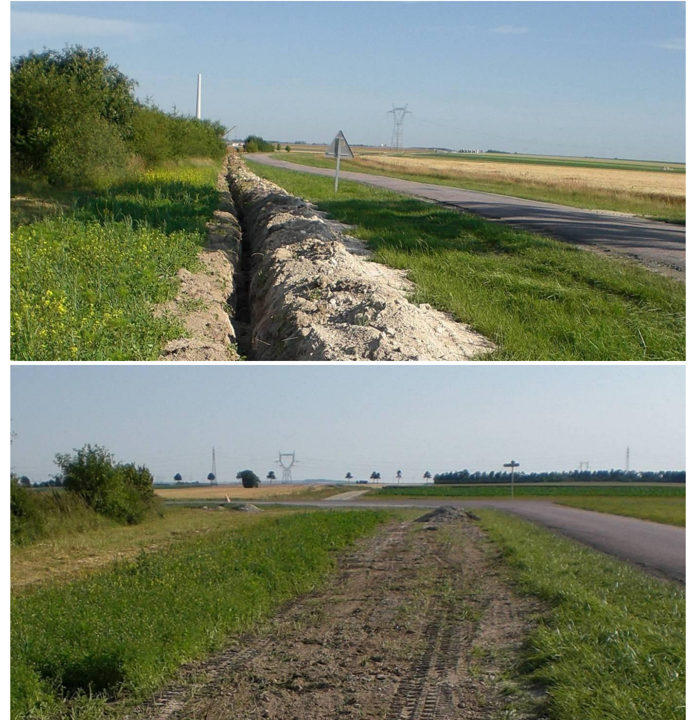
Photos 192 : Rebouchage de tranchée après passage des câbles électriques (Source : BE JC)
