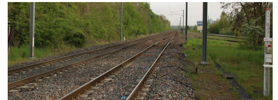
Photo 60 : Ligne de Châlons-en-Champagne à Reims-Cérès, à Recy (Source BE JC)
