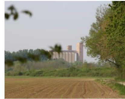
Photo 21 : Silo de Matongues, depuis la route entre Juvigny et Matongues (Source BE JC)
