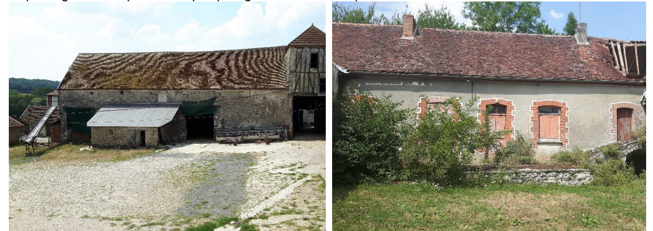
Figure 126 : Bâtis prospectés dans le cadre de la recherche de gîtes (Ecosphère, 2019)
