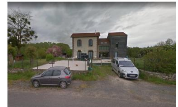
Figure 47 : Ancienne gare de Le Thoult-Trosnay reconvertie en habitation (Source : Google Streetview)
