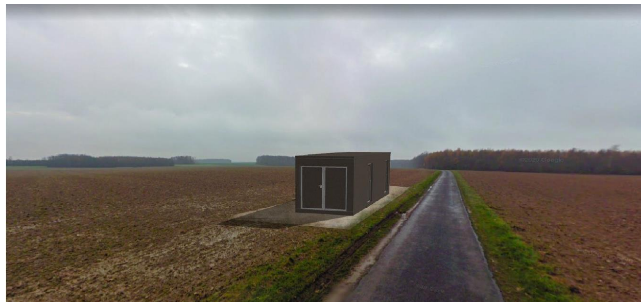
Figure 205 : Insertion du poste de livraison dans la zone d'implantation du projet (Source : BE JC d'après Google Streetview)
