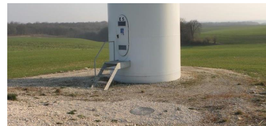
Figure 208 : Type d'aménagement de plateforme à privilégier (Ecosphère, 2019)
