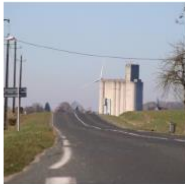
Vue lointaine sur le silo de Vauchamps, depuis le croisement entre la D311 et la D933 (Source : BE JC)
