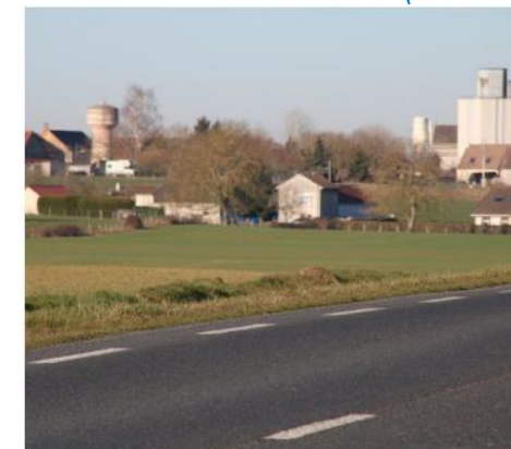
Château d'eau par rapport au silo et au village de Champaubert, depuis la D933 (Source BE JC)
