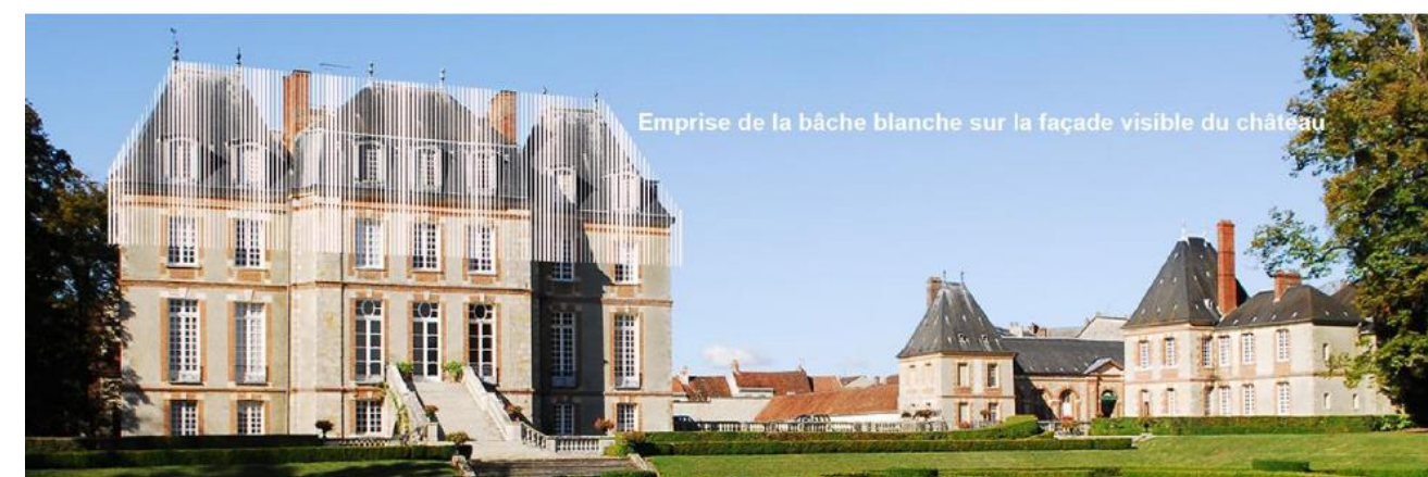
Figure 193 : Part de la façade Sud-est dissimulée sous la bâche blanche (Source : BE JC, d'après Champagne-Ardenne Tourisme)
