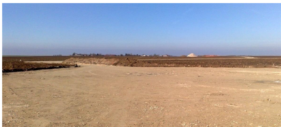
Figure 157 : Exemple d'aire de montage, grave compactée sur géotextile
