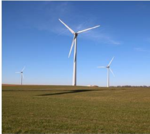
Parc de la Brie Champenoise, depuis le Nord de La Villeneuve-lès-Charleville (Source : BE JC)
