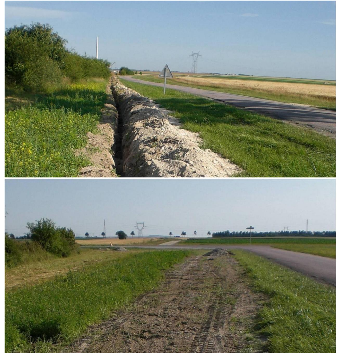
Photo 189 : Rebouchage de tranchée après passage des câbles électriques (Source : BE JC)
