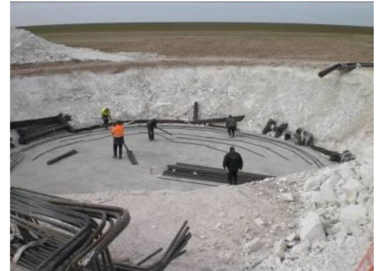
Photo 190 : Exemple de fondation à remettre en état (Source : BE JC)
