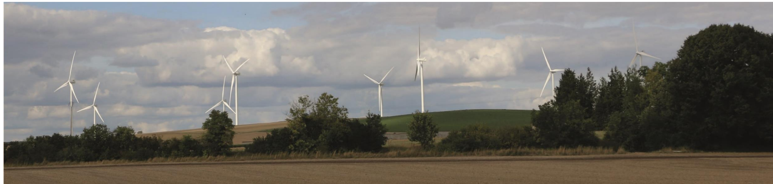
Figure 38 : Bien que proches de l'observateur (environ 1.8 km), les éoliennes du parc de la Croix Benjamin sont ici masquées en partie par la micro-topographie ainsi que par les rideaux de végétation (source : ATER Environnement, 2019)
