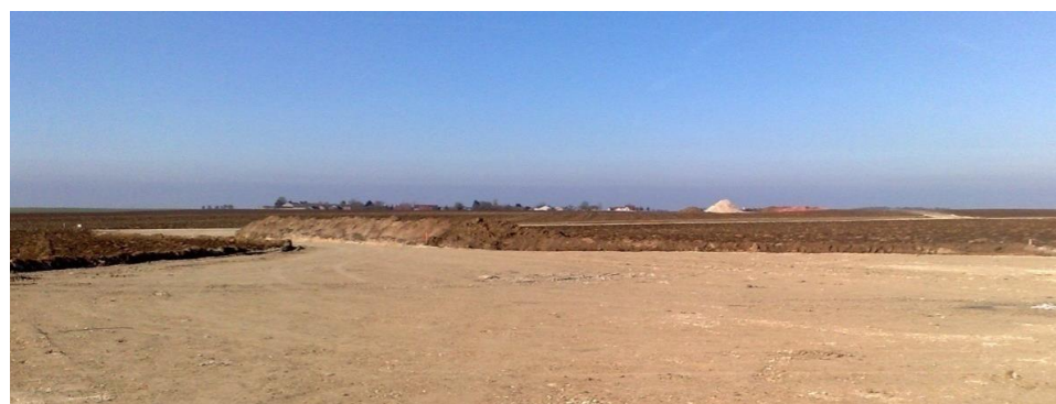
Figure 124 : Exemple d'aire de montage, grave compactée sur géotextile
