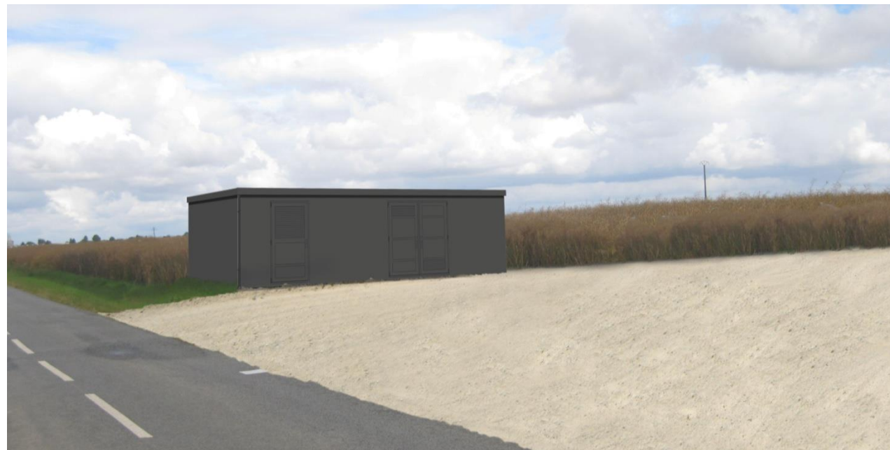
Figure 112 : exemple d'habillage d'un poste de livraison (source BE Visu)
