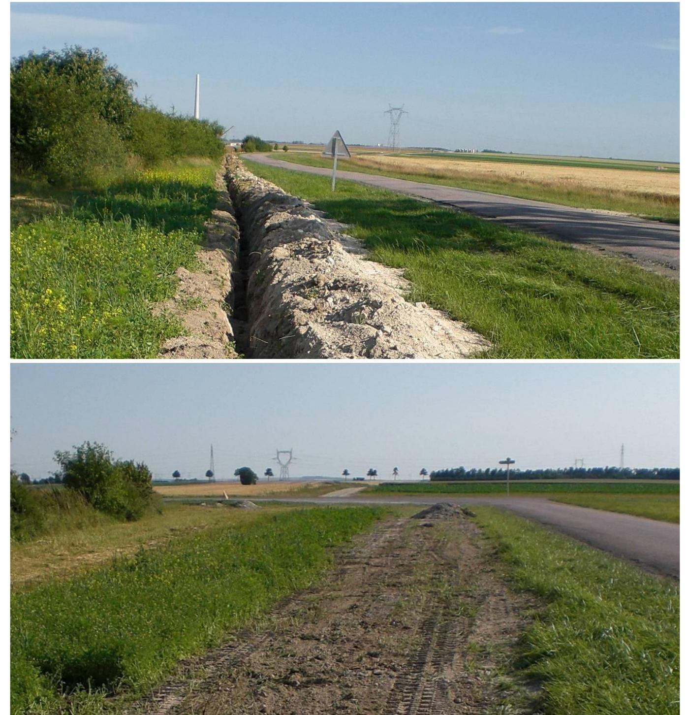
Photo 138 : Rebouchage de tranchée après passage des câbles électriques (Source : BE JC)
