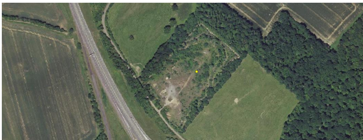
Figure 3 : Photo aérienne de l'ancienne plateforme autoroutière à Guillon-Terre-Plaine Source : GoogleMaps
