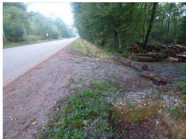
Fossé de bord de VC 5 et accès aux parcelles forestières au Sud du site
