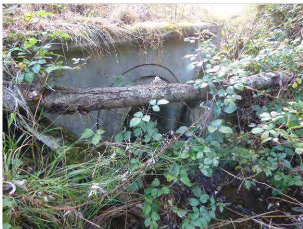
Fossé existant et busage en amont du site
