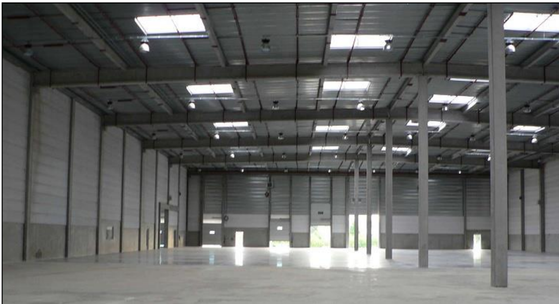
Figure 11 : Structures et parois d'une cellule type
